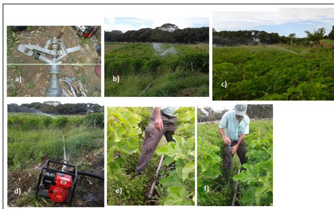
Figura 4. Sistema de riego por aspersión utilizado en la parcela de tempate: a) tipo de aspersores utilizados; b, c, d) sistema en funcionamiento; e, f) instalación de los aspersores, Alajuela, 2014.
