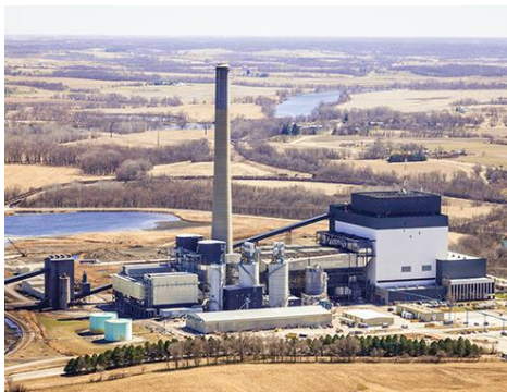
Figura 6. Estación de generación eléctrica Fuente: POWER Magazine, 2015
