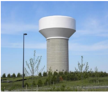
Figura 14. Tanque de agua elevado con plataforma de soporte integrada Fuente: www.caldwellwatertanks.com , 2018
