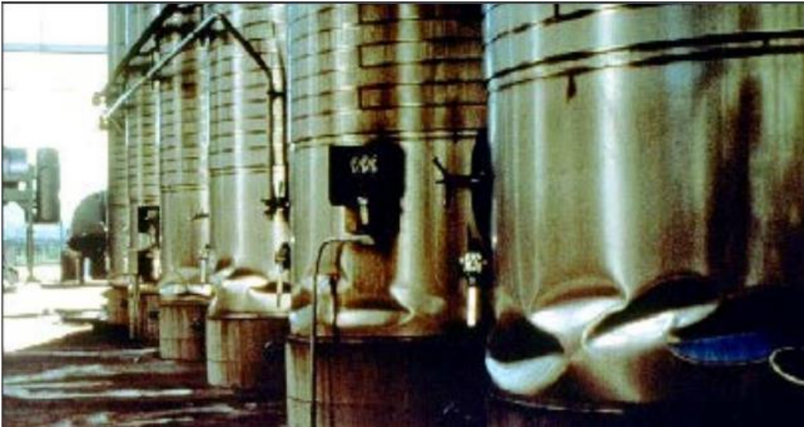
Figura 63. Falla en la base de una serie de tanques presurizados Fuente: FEMA, 2013
