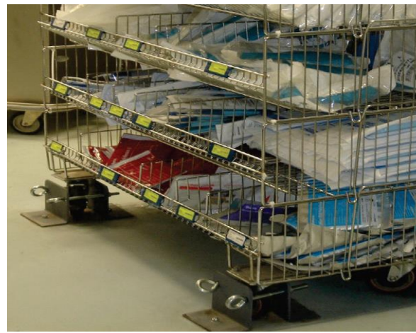
Figura 59. Anclaje de estantería metálica con patines y cadena
