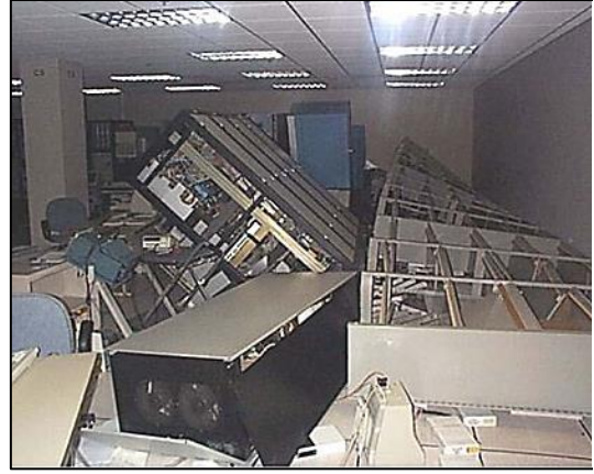
Figura 19. Estantes con equipo dañado por sismo en un centro de manejo de datos Fuente: DataCenterKnowledge.com, 2012
