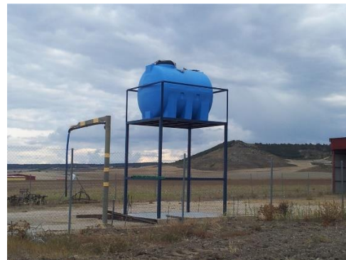
Figura 7. Tanque elevado Fuente: http://www.valorialabuena.com , 2019
