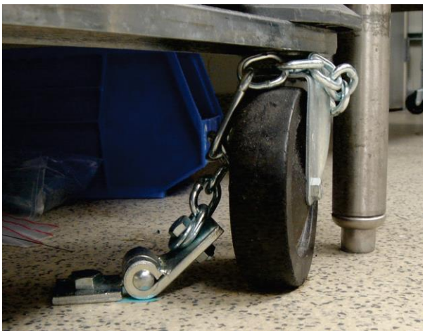
Figura 58. Anclaje de estantería metálica con rueda y cadena
