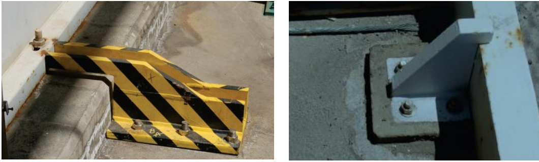
Figura 42. Ejemplos de apoyos que restringen el volcamiento o deslizamiento del equipo (acero a la izquierda y concreto a la derecha)
