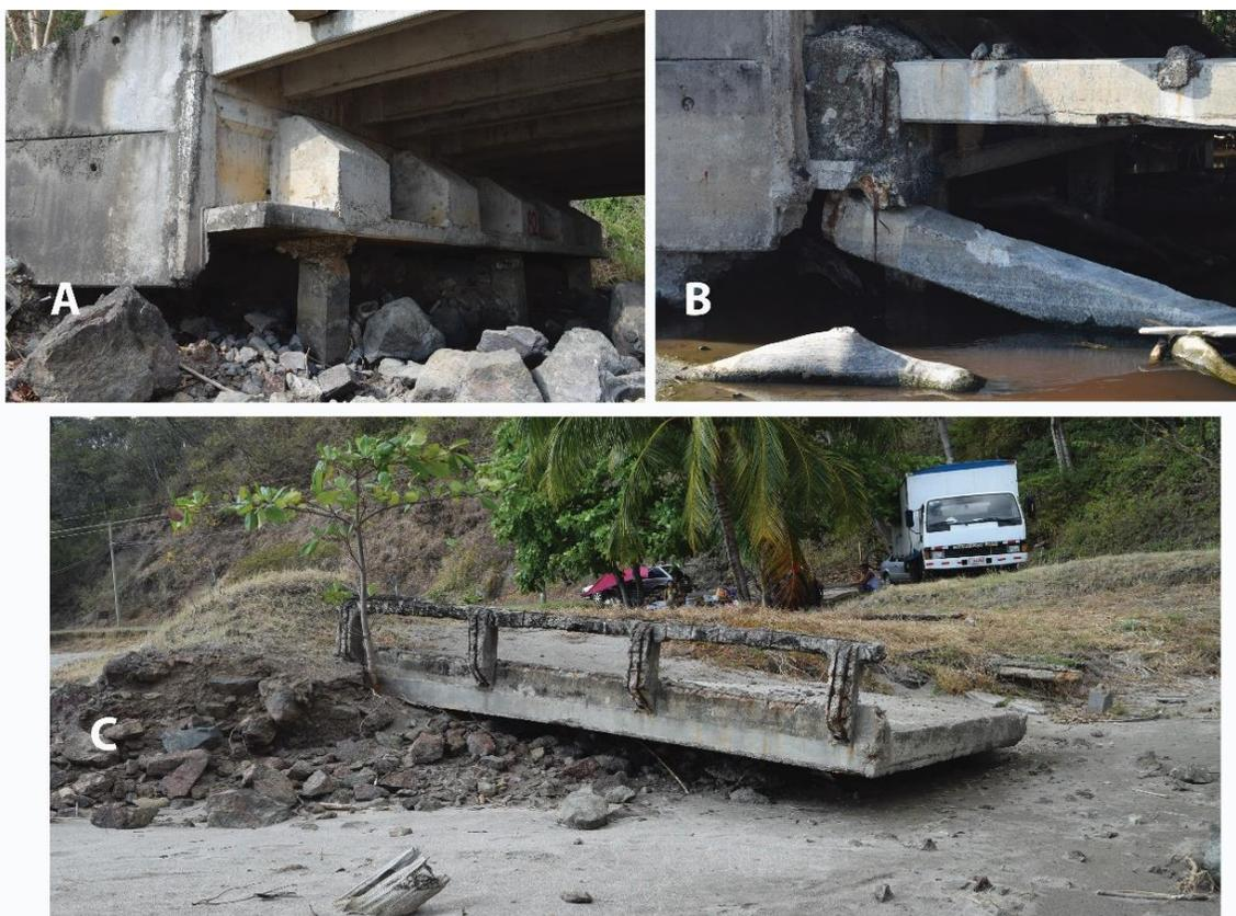
Figura 50. Daños en algunos puentes de playa Carrillo. A y B: Detalle de fundaciones deterioradas debido a la remoción de sedimento de los puentes en playa Carrillo (Fecha: 21/1/2018. Coordenadas: 335611,08 E; 1091700,24 N). C: Puente desarticulado y removido por la acción del mar (Fecha: 21/1/2018. Coordenadas: 336733,46 E; 1091911,28 N).
