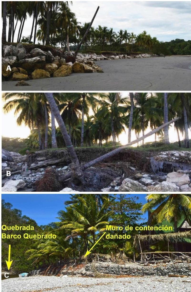
Figura 49. Daños con nivel 4 y 5 en Sámara y Barco Quebrado. A: Barrera de rocas que protege la línea de palmeras, vista general. B: Barrera de rocas parcialmente destruida (Fecha: 20/11/2017. Coordenadas: 332026 E, 1092675,4 N). C: Casa que posee muro de contención dañado debido a la erosión (Fecha: 15/1/2018. Coordenadas: 325237,5 E, 1094078 N).
