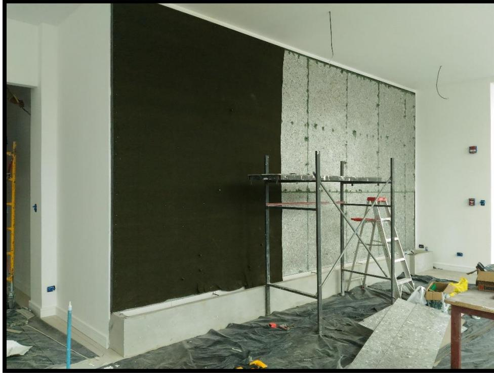
Figura 38. Colocación del geotextil
