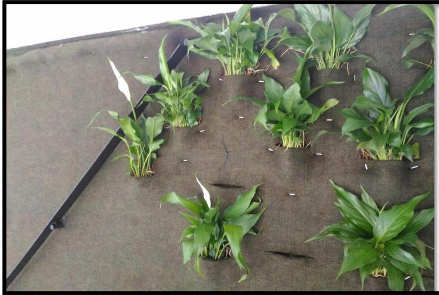
Figura 41. Colocación de las plantas en el geotextil
