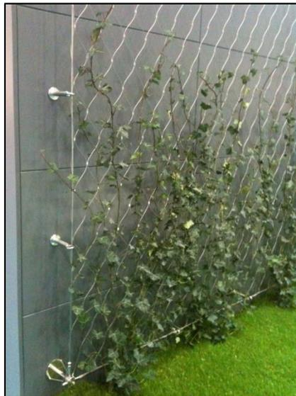
Figura 6. Jardín vertical instalado sobre malla metálica
