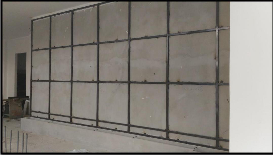
Figura 36. Colocación de la estructura sobre la pared existente
