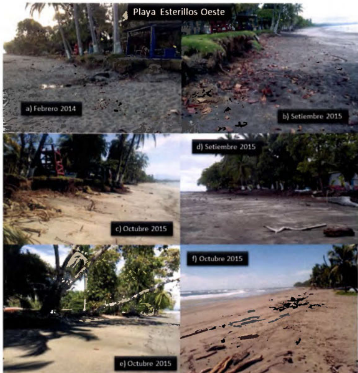
Figura 4-6 Impactos de la erosión en Playa Esterillos Oeste. a) relleno en la playa con salida de alcantarillado público, b) y c) relleno con material arcilloso y terraza de erosión, d) y e) terrazas de erosión mayor a 50 cm y vegetación volcada hacia la playa, f) vista de la playa hacia el oeste.
