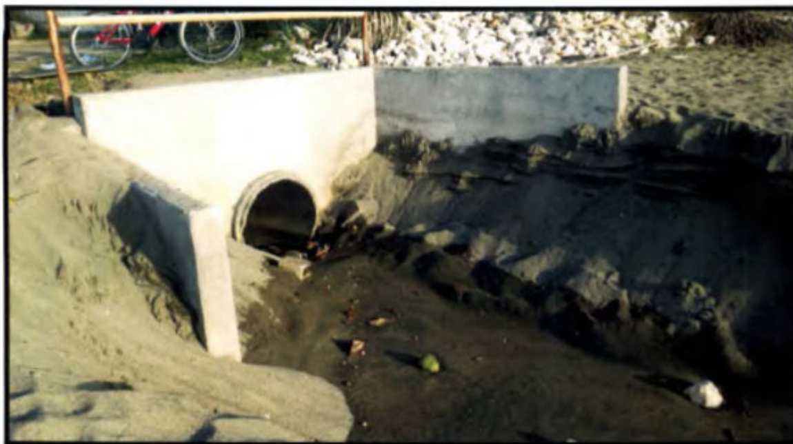
Figura 3-13 Alcantarilla en Playa Potrero. Tomada el 27 de agosto, 2015.
