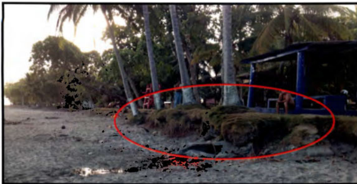
Figura 3-12 Alcantarilla en Esterillos Oeste. Tomada por Omar Lizano el 11 febrero, 2014.
