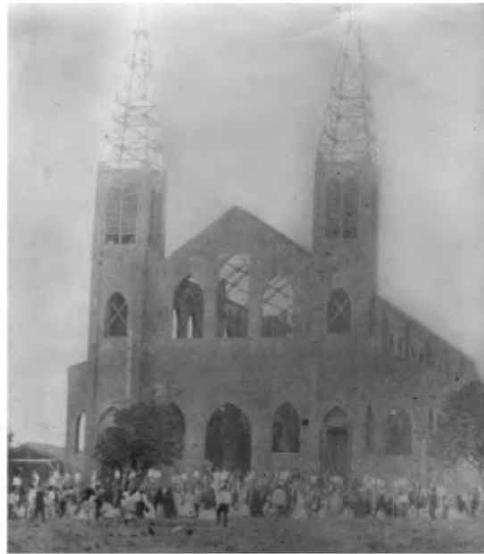
Fotografía 19. Construcción de Iglesia Metálica de Grecia 1894. Fuente: Archivo de Gómez Vargas, S.
