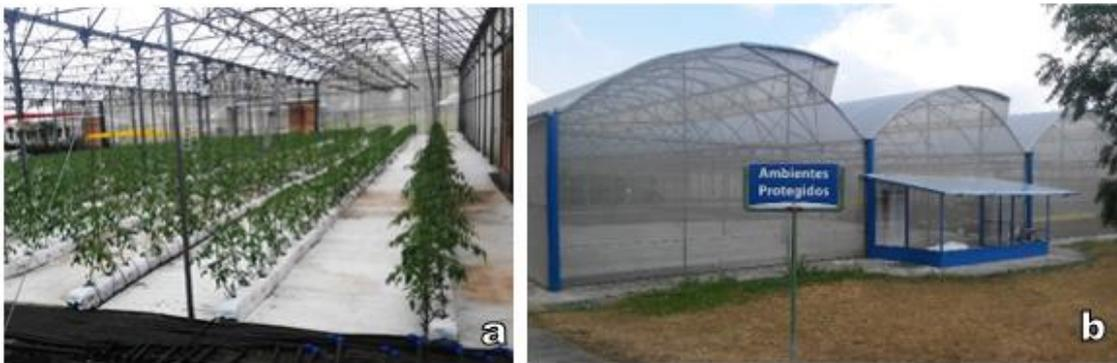
**Figura 2.** Vista interior (a) y exterior (b) del invernadero tipo semiarco multicapilla utilizado para el experimento.
