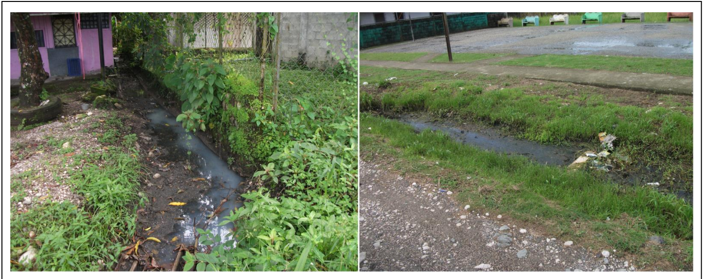
Fotografía 8: Contaminación por descarga de aguas negras sobre la vía pública en el poblado de La Esperanza de Río Claro.
