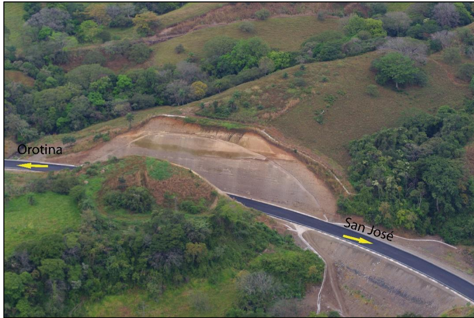
Figura 14. Ejemplo de “Corte en cajón”, corte sub-vertical en los taludes a ambos lados del camino. Se observa la morfología típica de la zona de estudio y el corte > 55^\circ de inclinación realizado para crear la carretera. El flujo del agua en este tipo de corte es hacia los lados del talud y hacia el frente donde se realizó el corte. Imagen aérea cortesía de fotosaereascr.com ® . Estas fotografías son de los años 2008-2009, previas a la apertura de la carretera. Flechas amarillas sobre la carretera, hacia la izquierda el sentido Orotina y, hacia la derecha, el sentido San José.
