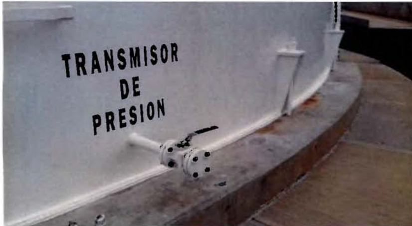
Figura 60. Sistema para conectar transmisión de presión.
