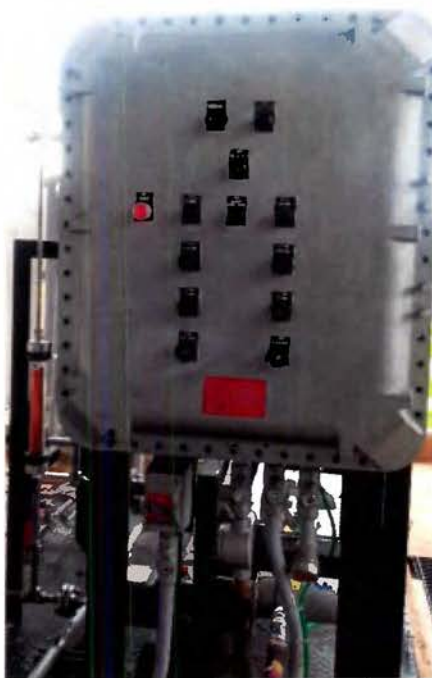
Figura 51. PLC para controlar llenado y vaciado de tanque de combustible JET (para aviones).
