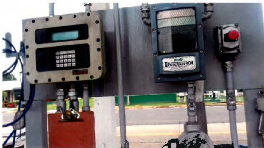
Figura 83. Unidad de control para cargar cisternas.
