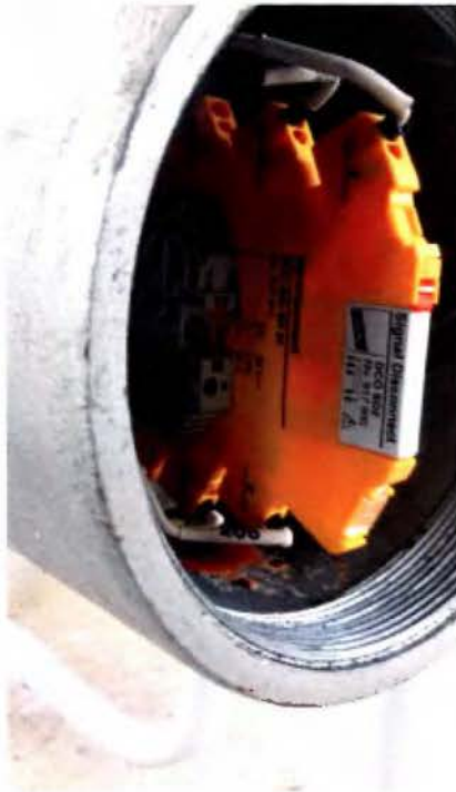
Figura 85. Otro supresor de transitorios en unidad de control de carga de cisternas.
