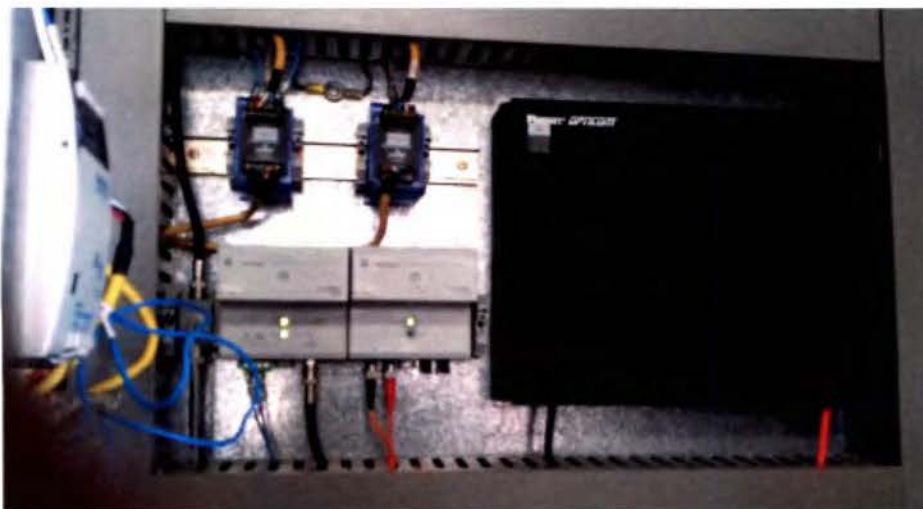
Figura 68. Caja de conexión de fibra óptica (caja negra).
