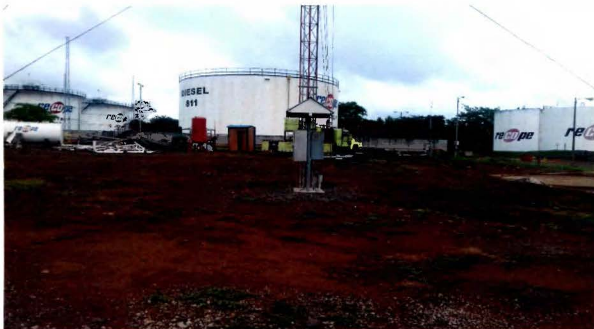
Figura 49. Tanques de almacenamiento de combustible.
