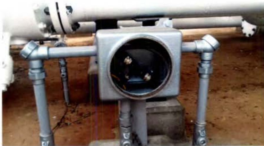
Figura 54. Válvula motorizada.
