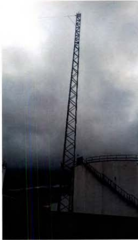
Figura 58. Sistema de pararrayos: catenaria.
