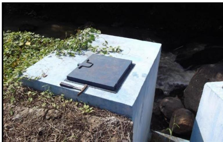
**Figura 21. Primer tanque de captación de la naciente Cebadilla. La piqueta de la figura tiene 28 cm de largo**
