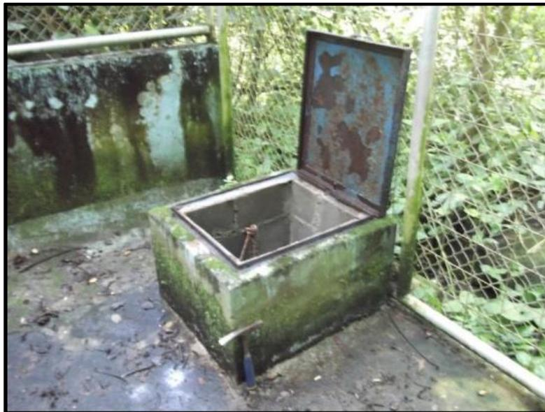
**Figura 14. Tanque de captación de la naciente Laguito Phillips. La piqueta que aparece en la figura tiene una longitud de 28 cm.**
