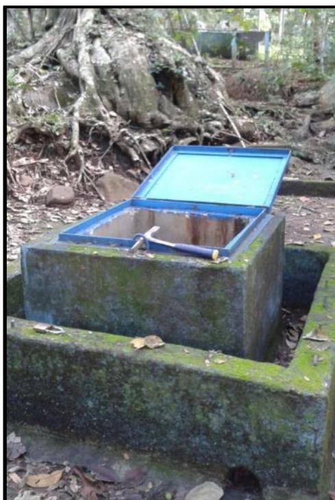
**Figura 27. Tanque de captación de la naciente Los Llanos. La piqueta que aparece en la figura tiene una longitud de 28 cm.**
