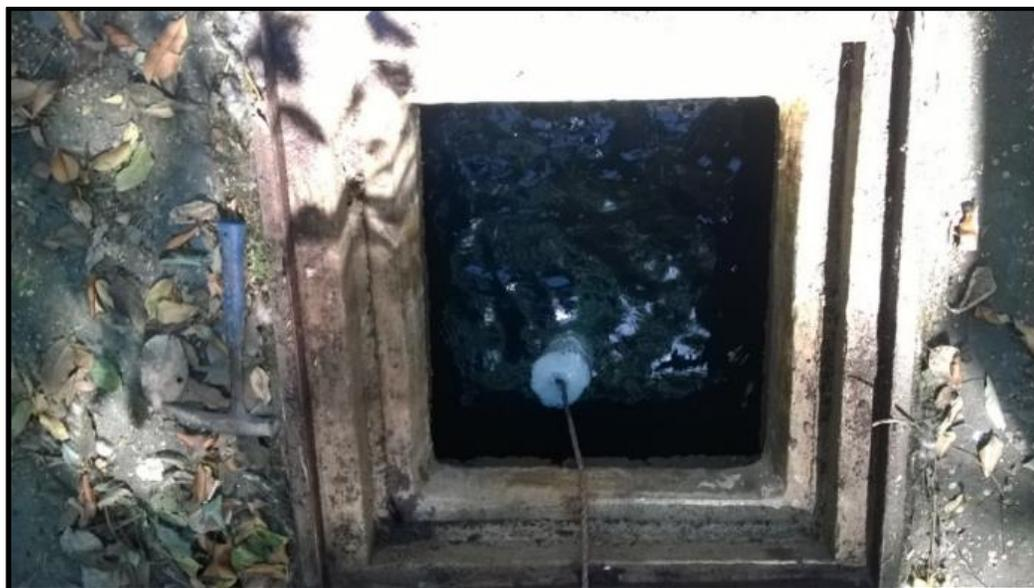
**Figura 40. Vista superior del tanque de cloración de la naciente Caimitos.**
