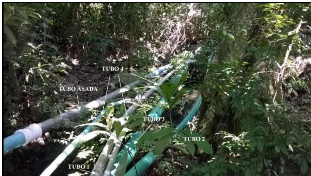
Figura 29. Tubos para los cuales se utilizó el caudalímetro en el manantial Los Llanos.
