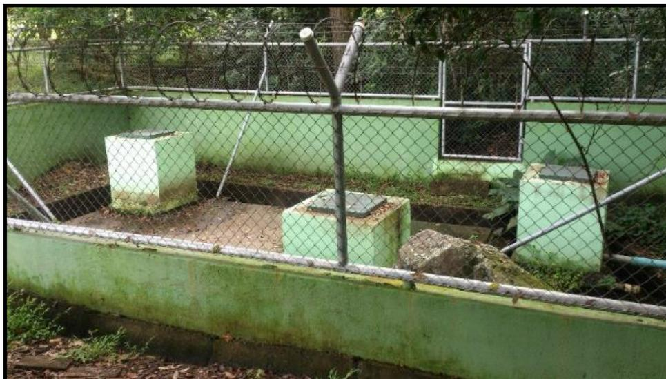
**Figura 32. Tanque de Captación de los manantiales Los Herrera.**
