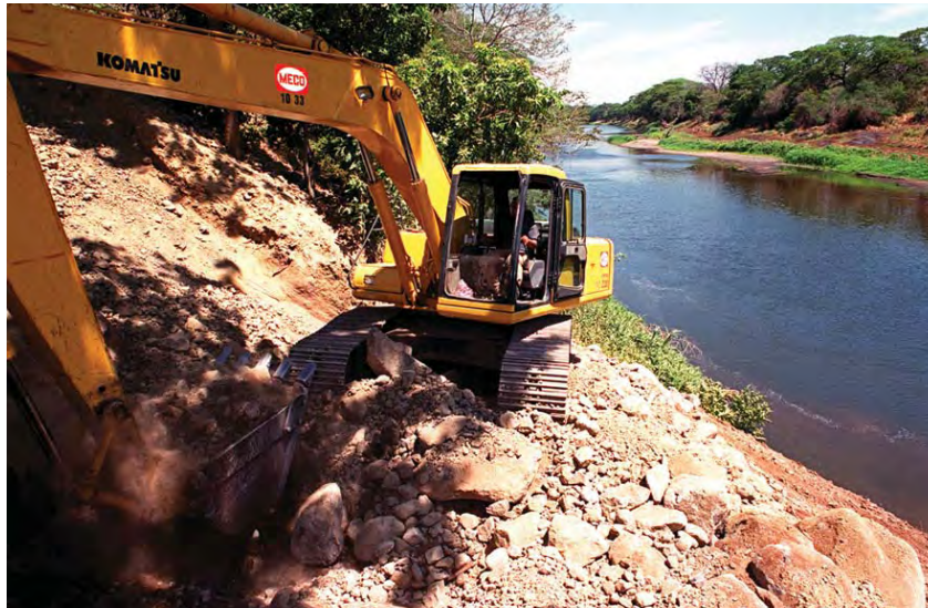
Foto 13: Reparación del dique (Tempisque), temporada seca en Filadelfia. Fuente: Al Día.
