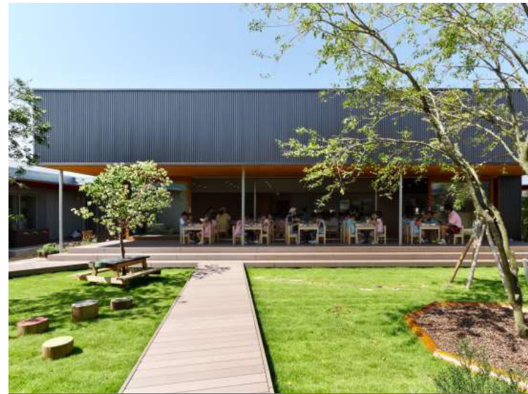
IMAGEN 29: Espacios semiexteriores (2014). Apertura del espacio de comedor hacia el patio >>Fuente: Studio Bauhaus
