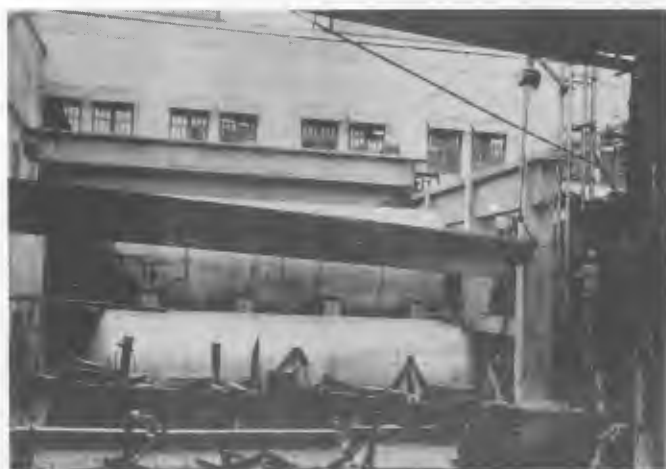
Fig. 19 Erección de vigas de 9.70 mts de luz
