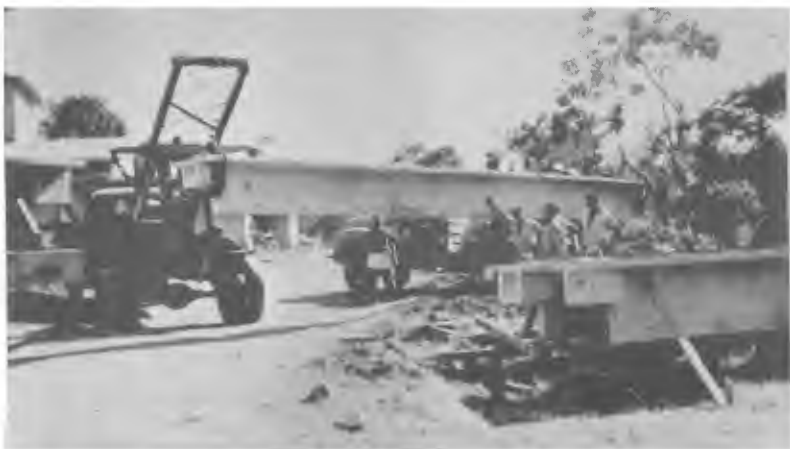
Fig. 19 Erección de vigas de 9.70 mts de luz
