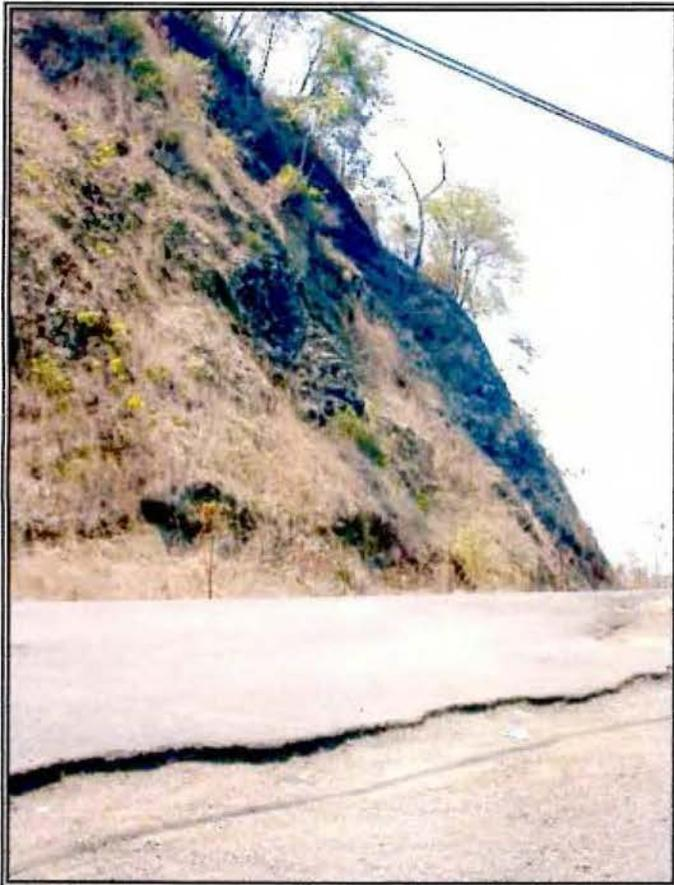
**Foto No. 12:** Problema de estabilidad del talud, se tiene una pendiente elevada, formación geológica y edáfica favorables a propiciar la caída de materiales.
