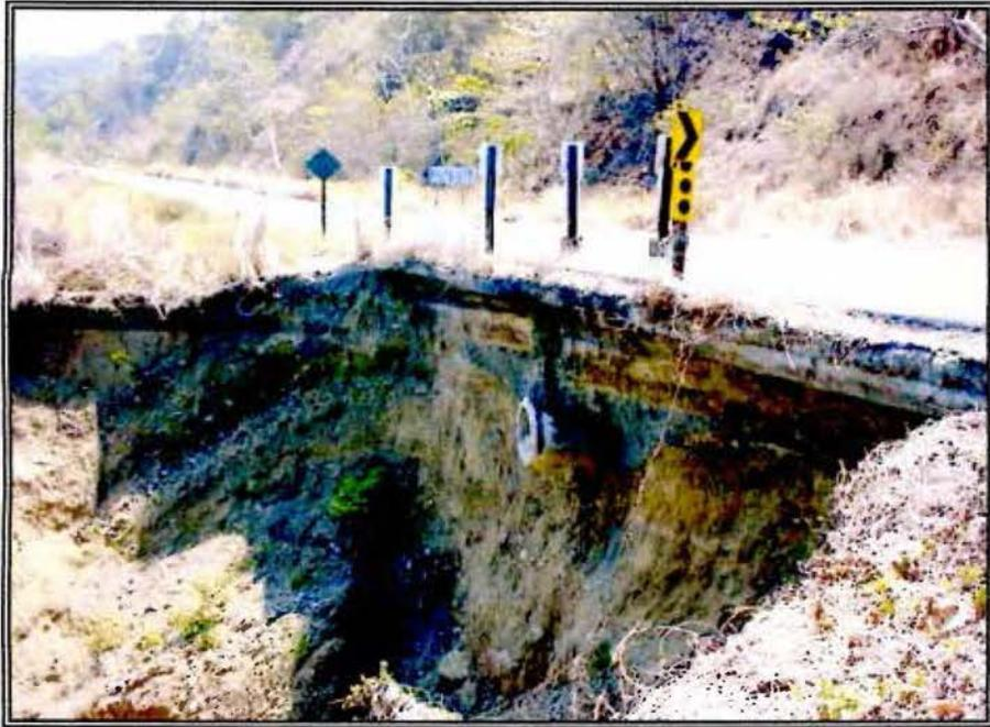
**Foto No. 11:** Problema de socavación, dado por los cambios en la hidrología superficial y el poco mantenimiento a las obras de drenaje.
