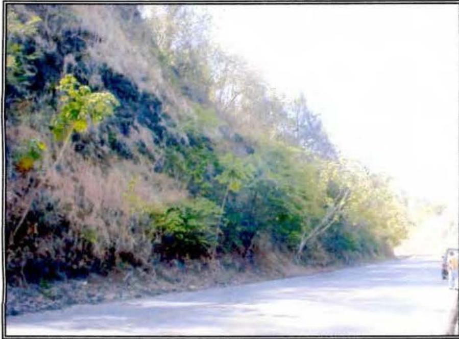
**Fotos No. 9 y 10:** Cortes de talud realizados para el paso de la carretera. Estos se encuentran ubicados en la zona montañosa antes de llegar a Jacó.
