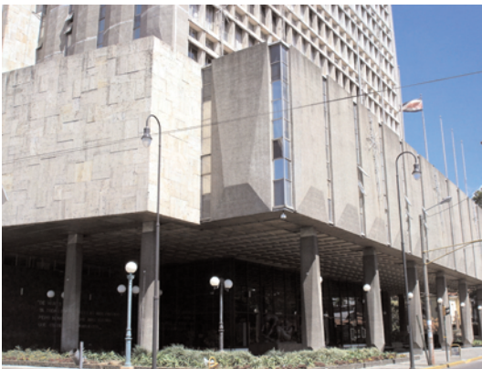
Figura N° 5.70. Fachada del Instituto Nacional de Seguros. 2005.
