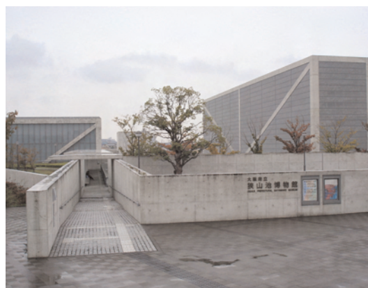
Figura N° 5.34. Rótulo principal del Osaka Prefectural Sayamake Museum, Japón 2004.
