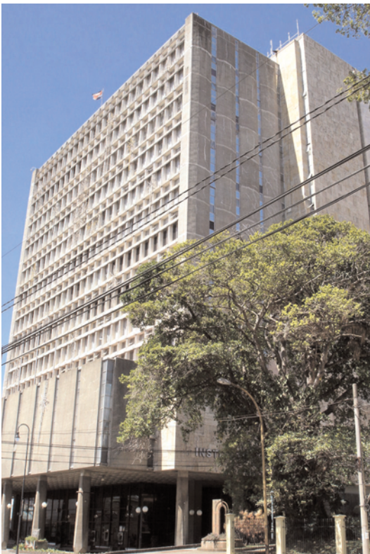
Figura N°1.7. Fachada del Instituto Nacional de Seguros (INS). 2005.
