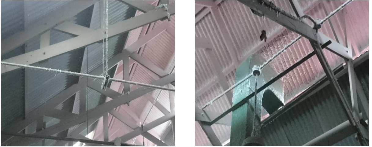
Figura 3. Fotografías de techos, ductos y cerchas en el área de planchado.
