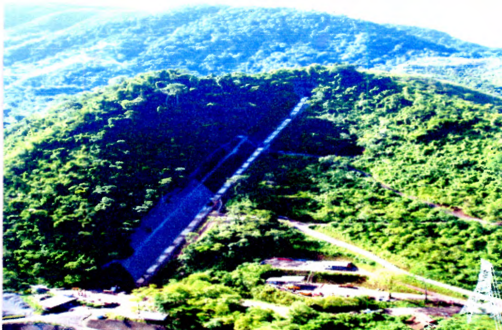
Figura 40. Fotografía de la trinchera donde se ubicará la tubería blindada de acero de 400m de longitud. Fuente: P.H.Pirrís, marzo 2009.
