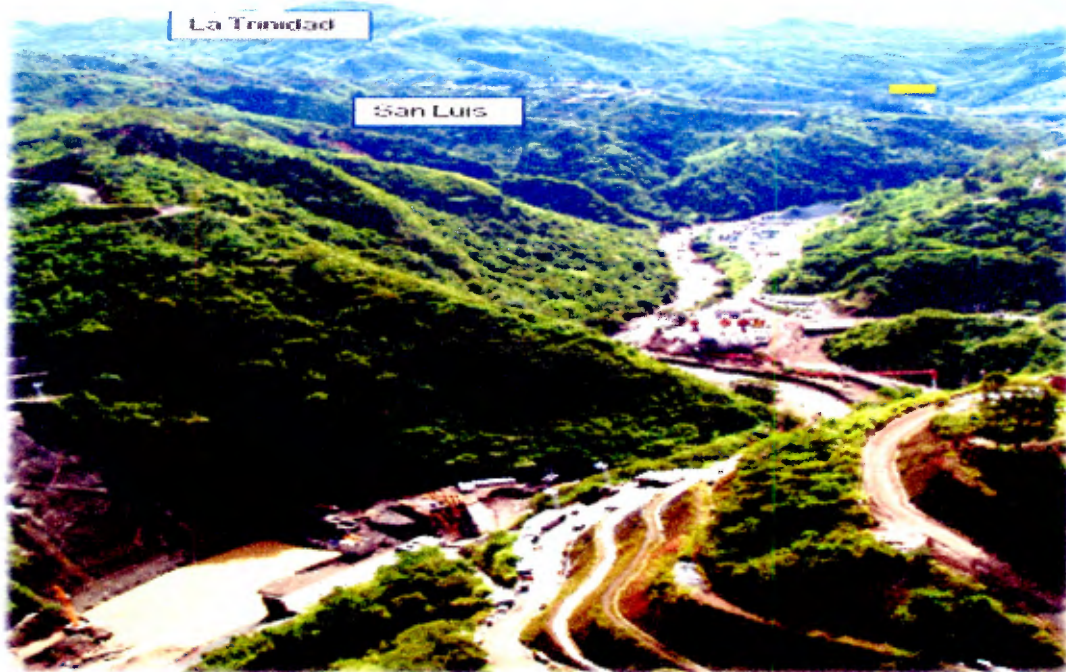
Figura 39. Fotografía de la ubicación de la represa y embalse sobre el río Pirrís .
