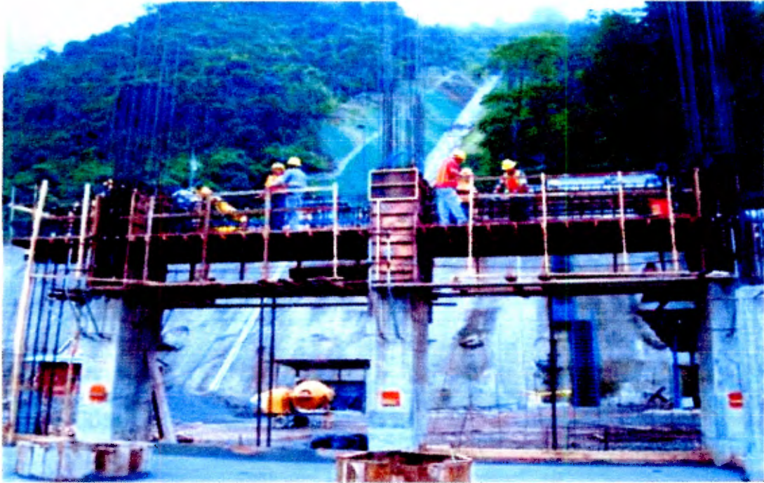
Figura 42. Fotografía del avance de la construcción de casa de máquinas, Parrita
