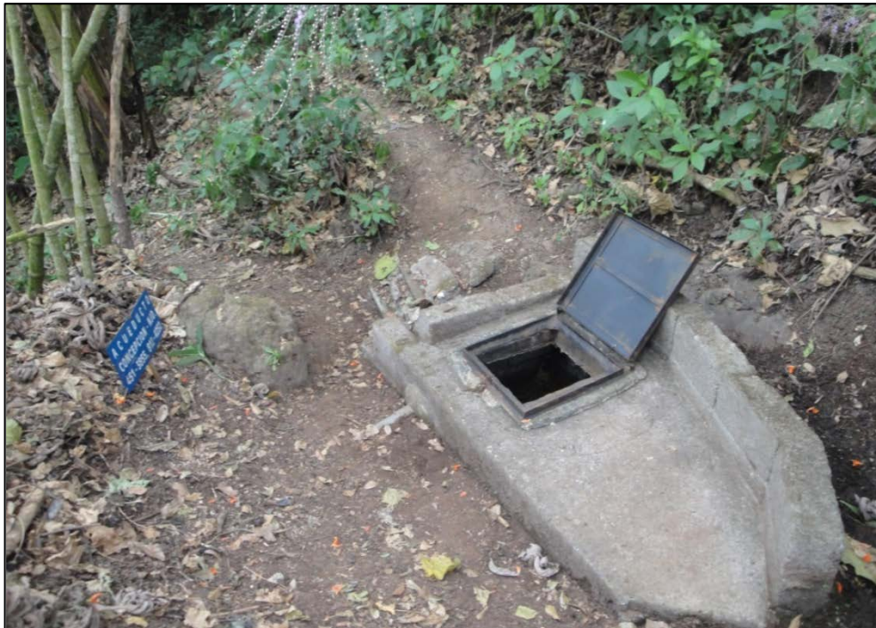
Figura 3.11: Fotografía de la captación en la naciente La Bomba.
