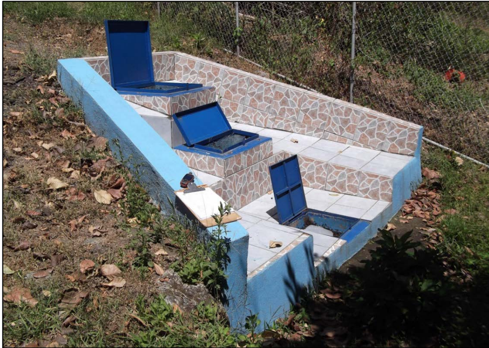
Figura 3.3: Fotografía de la captación en la naciente Santa Margarita 1.
