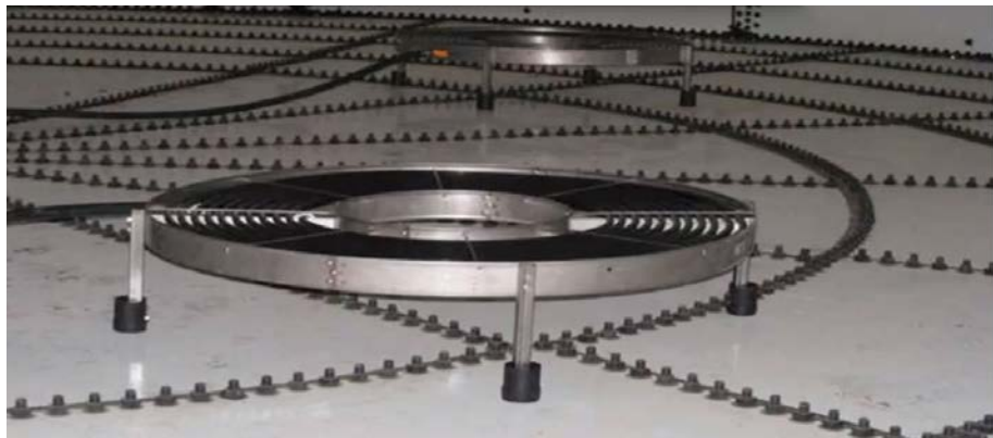
Figura 7.4 Aireadores por difusión. (diffusion, 2014)
