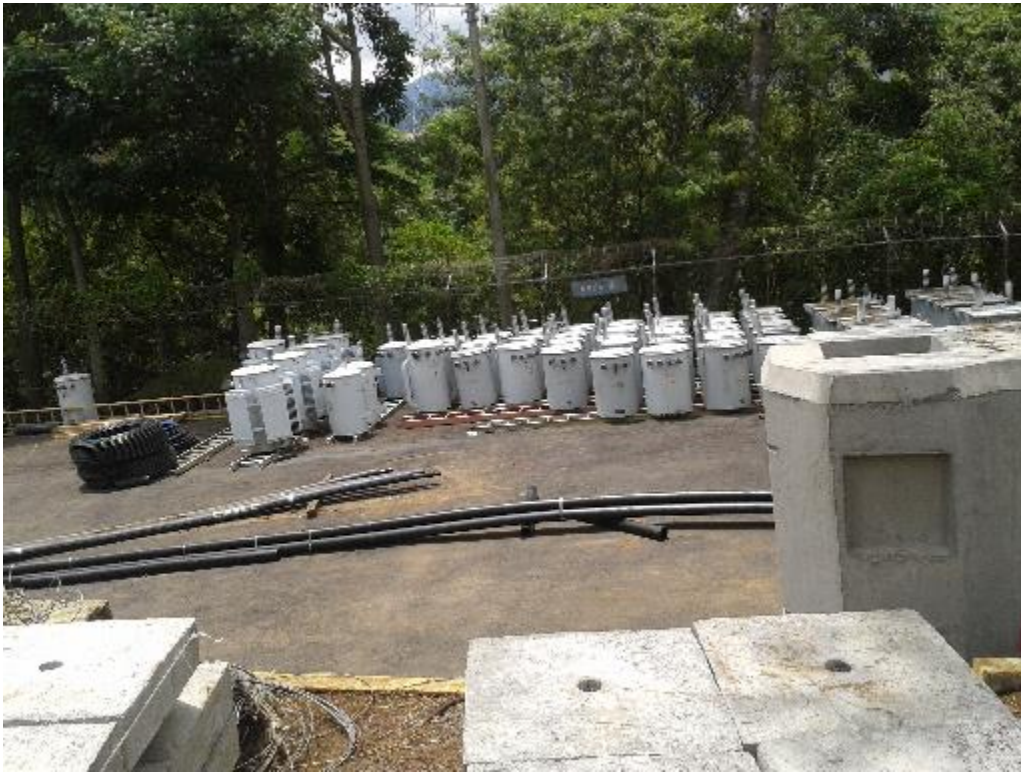
Figura 4.14. Calle del plantel que conduce hacia las bodegas de PCB's
