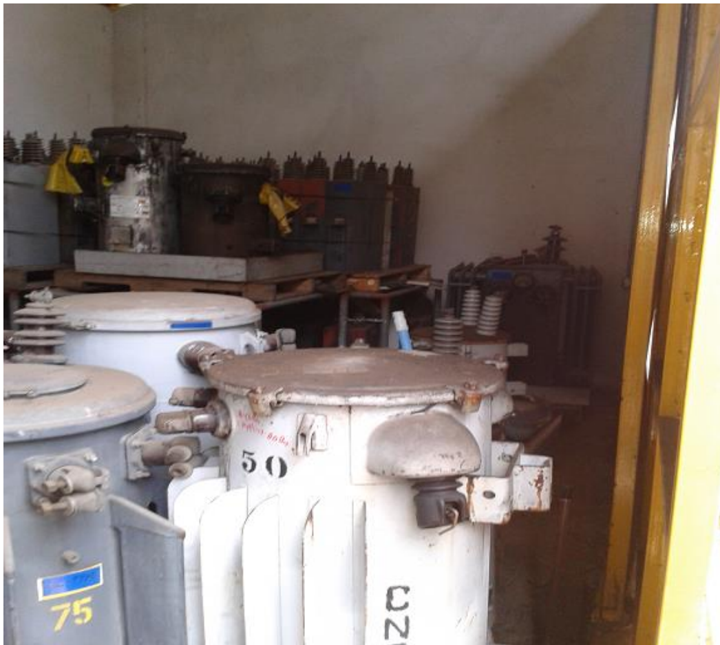
Figura 4.8. Disposición espacial de los contenedores de aceite contaminado en las bodegas
