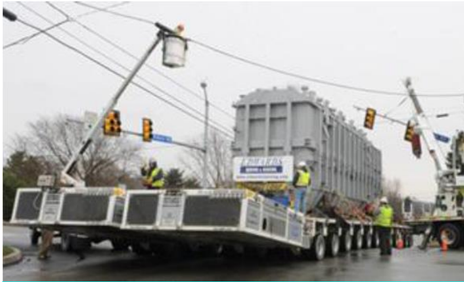
Figura 4.19. Transporte de un transformador de potencia por vía pública (U.S Department of Energy, 2012)
