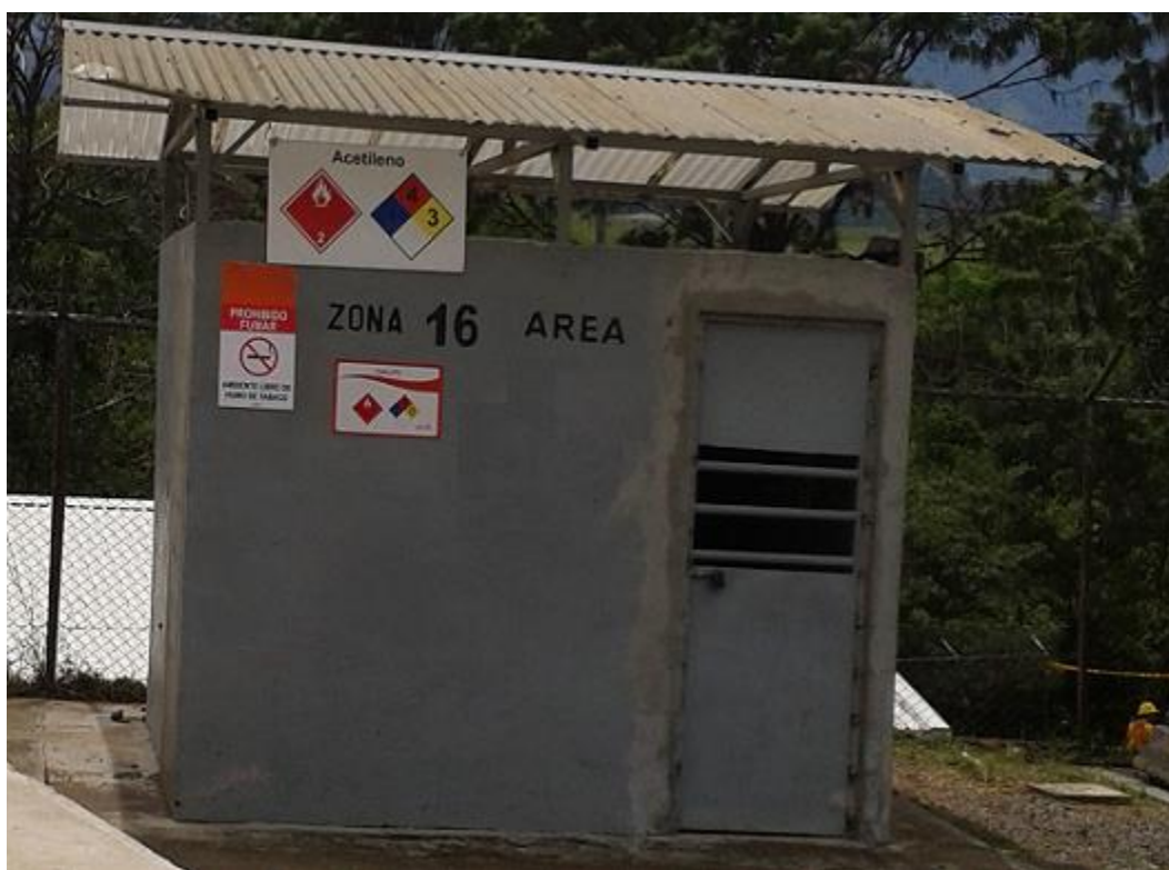
Figura 4.12. Bodega de cilindros que contienen acetileno y LPG
