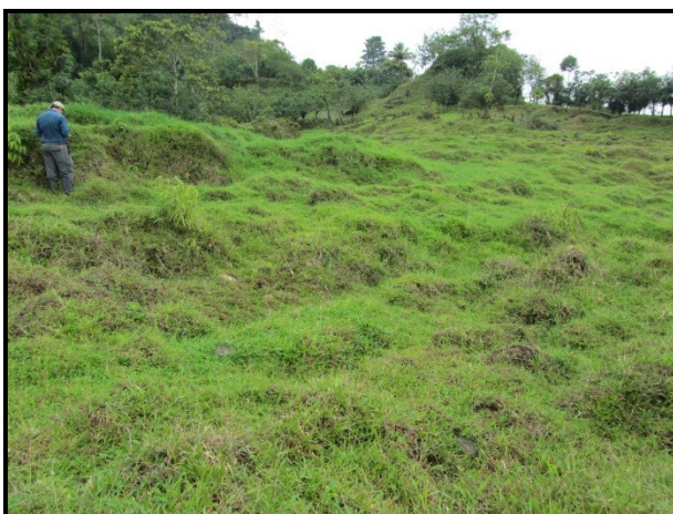
Figura 3.5. Antiguas coronas de deslizamiento. Coordenadas Este: 542303 Norte: 1110833 Fuente: Michael Calderón Q
