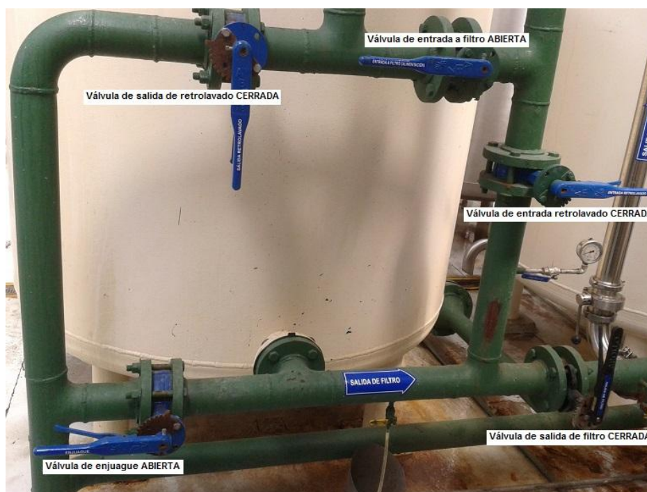
Figura 4.14 Esquema de tuberías para realizar enjuague rápido
