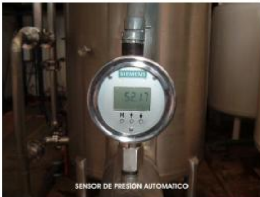
Figura 4.6. Sensor de presión automático.
