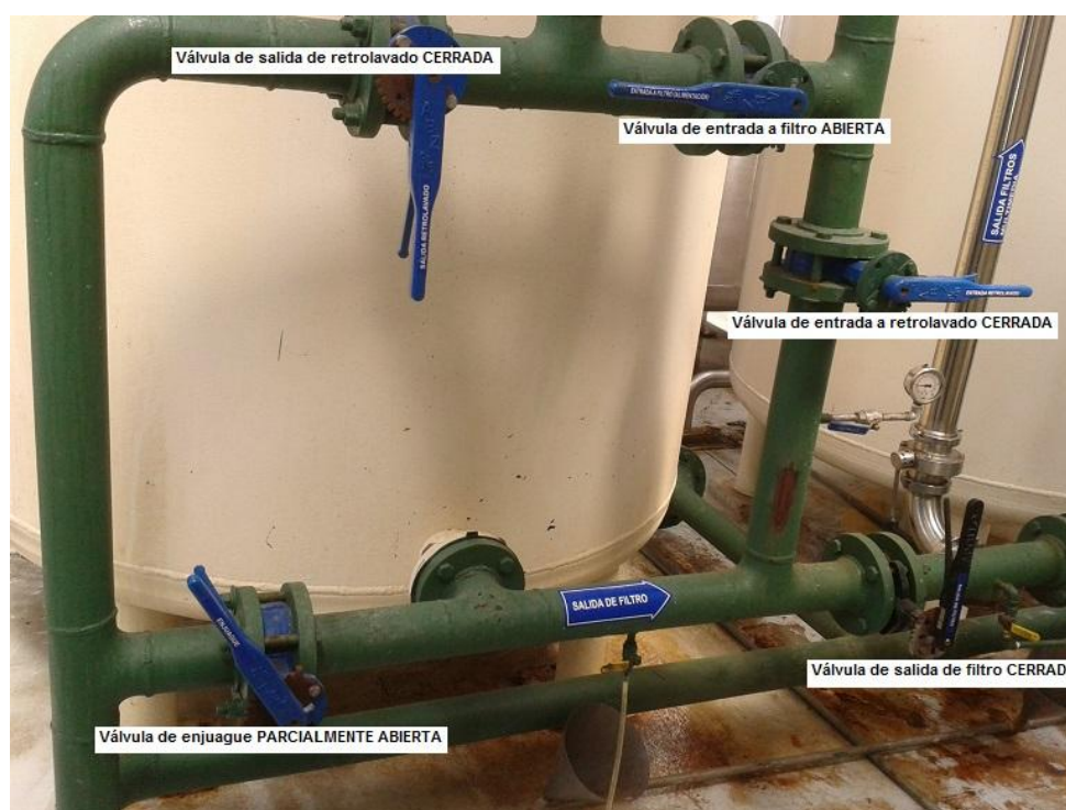
Figura 4.15. Esquema de tuberías para realizar un enjuague lento.
