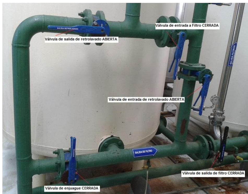
Figura 4.13. Esquema de tuberías para realizar retrolavado
