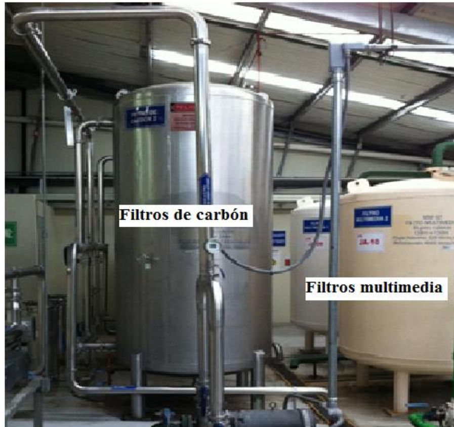
Figura 4.9. Filtros multimedia y filtros de carbón.
