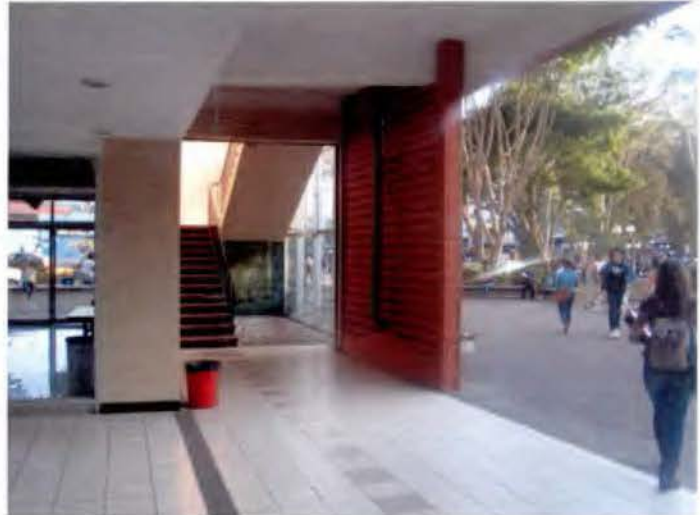
Imagen 4.18 Imagen original de espacio interno de la obra
