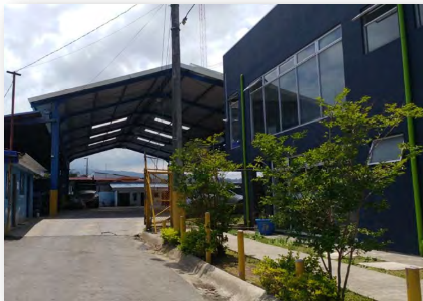
Imagen N° 5. Visita al plante de la municipalidad de Montes de Oca en Sabanilla, 2020
