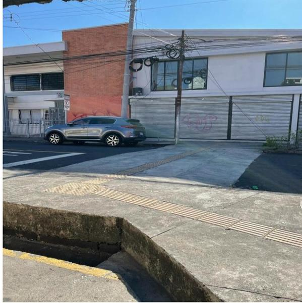
Figura A 7. Ejemplo de intersección a nivel de acera
