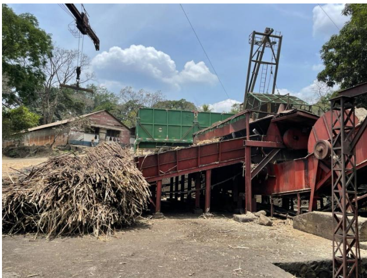
Figura 6: Lugar de recepción y descarga de la caña en el Ingenio Porvenir. Fuente propia.
