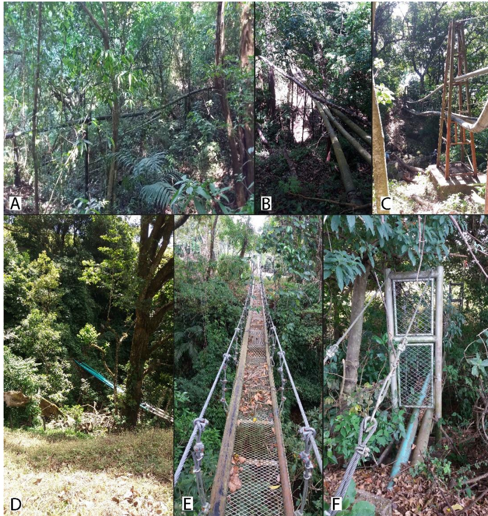
Figura N° 4.40: Pasos elevados. A) sobre la quebrada Naborí, entre las nacientes José Maclovio y Minas (487896 E / 1113997 N). B) sobre la quebrada Naborí (487865 E / 1113773 N). C) sobre el río Porrosatí (487884 E / 1113627 N). D) sobre afluente del río Porrosatí (487939 E / 1113536 N). E) sobre el río Zanjón (487564 E / 1112451 N). F) sobre afluente del río Zanjón (487616 E / 1112376 N). (Foto A-D: Hernández, 21 de diciembre del 2021; Foto E-F: 16 de febrero del 2022).
