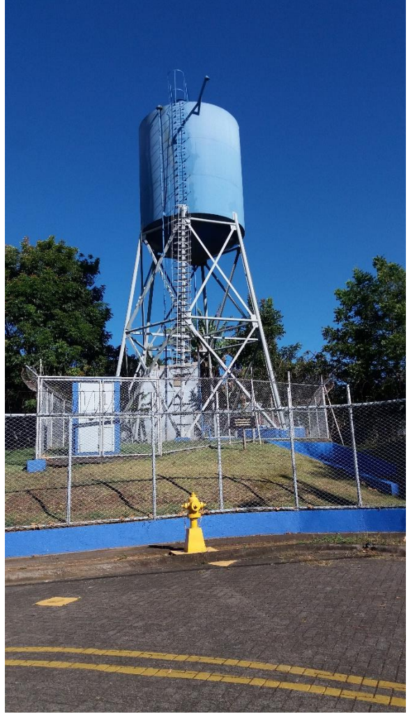
Tanque de almacenamiento Doña Elena.
