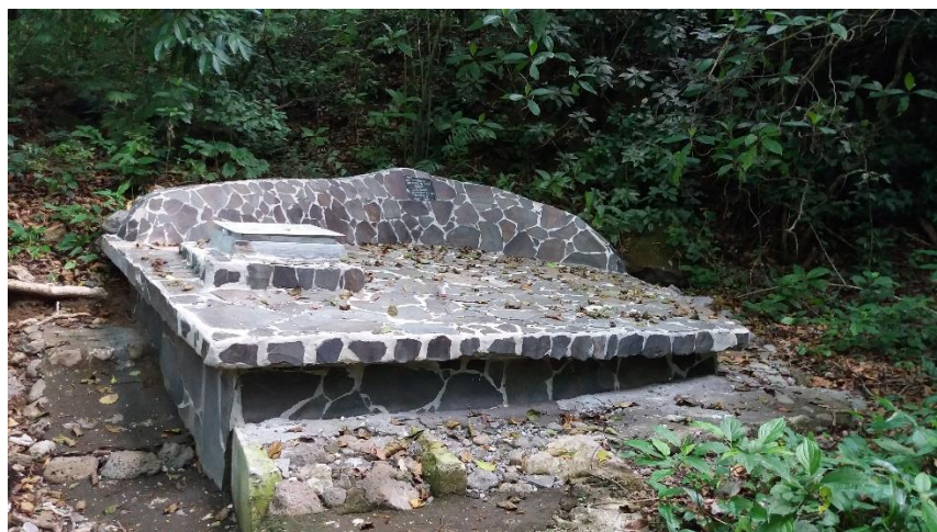
Tanque de captación de la naciente Calle Segura.
