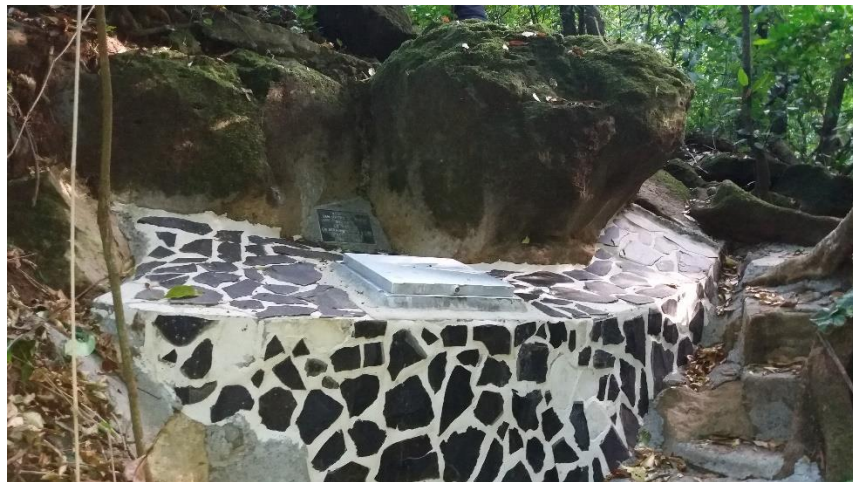
Tanque de captación de la naciente La Piedra.
