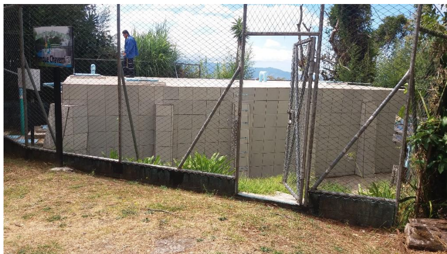
Tanque de almacenamiento Chaverri.
