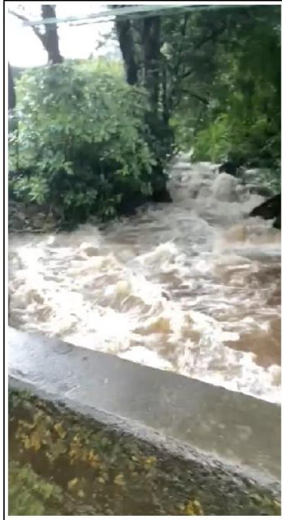
Figura N° 4.42: Puente sobre el río Porrosatí en San José de la Montaña (coordenadas 488290 E / 1113987 N), se observa la crecida en el río producto de las intensas lluvias (Municipalidad de Barva, 2021).
