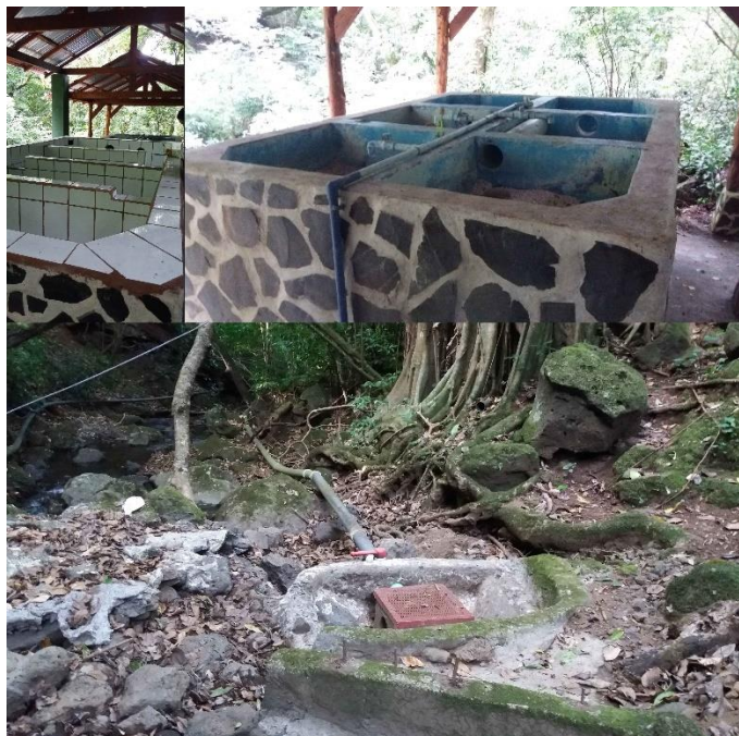
Filtro de agua quebrada Naborí.
