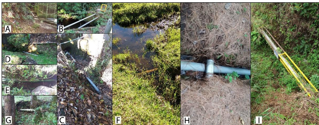
Figura N° 4.52: Zonas de tubería de conducción y distribución expuesta, ASADA San Pedro de Barva. (Foto: Hernández, 2 de diciembre del 2021).
