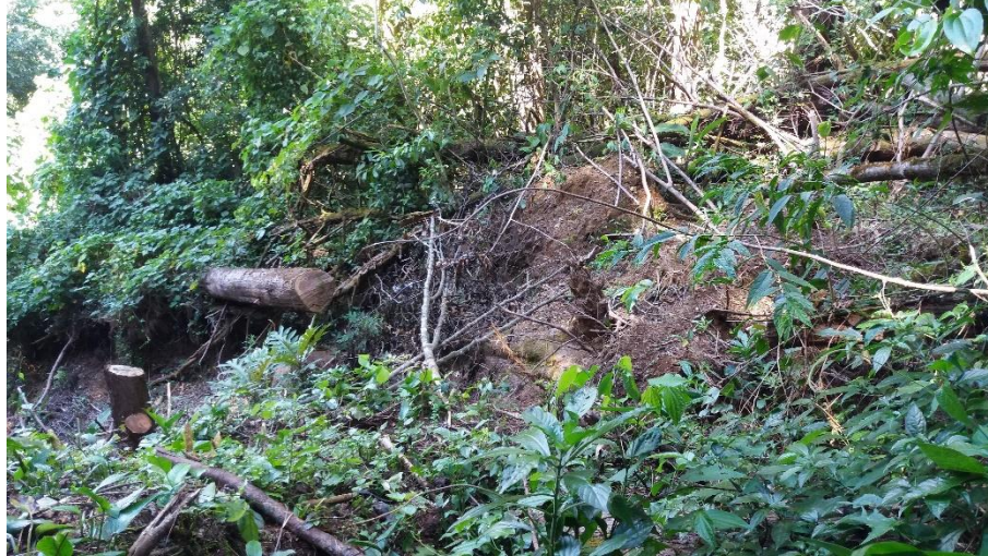
Figura N° 4.41: Movimiento de tierra sobre la quebrada Naborí, cerca del camino por donde pasa la tubería de conducción de la ASADA de San José de la Montaña (487957 E / 1113901 N). (Foto: Hernández, 21 de diciembre del 2021).
