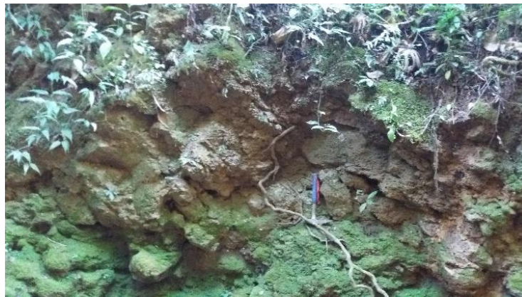
Figura N° 4.28: Afloramiento observado en la tubería de conducción del acueducto San Pedro sobre el río Porrosatí correspondiente a depósitos de avalanchas laháricas. (Foto: Hernández, 2 de febrero del 2022).
