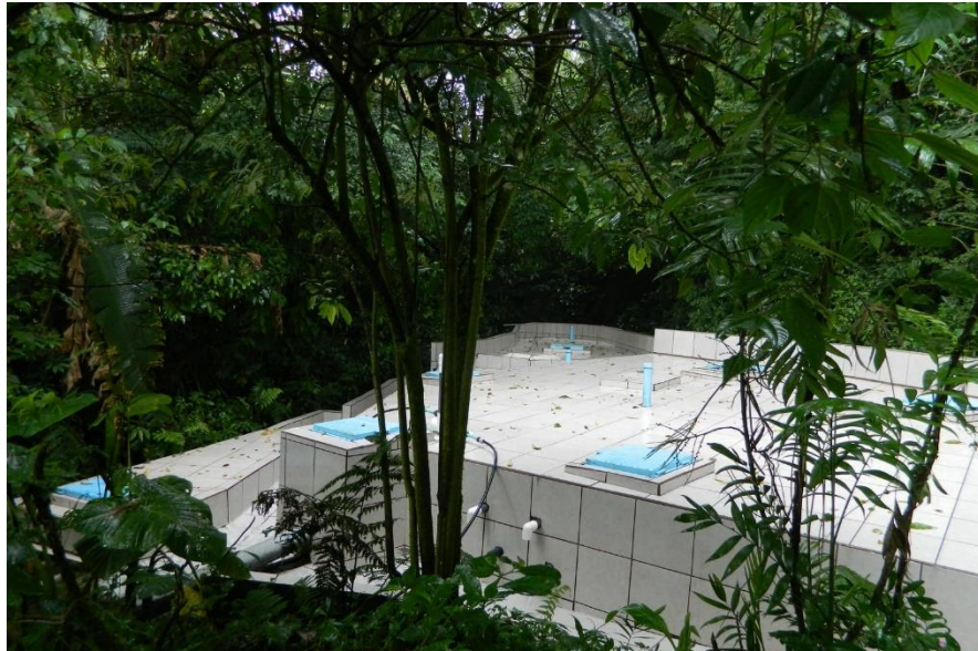
Tanque de captación de la naciente San Miguel.
