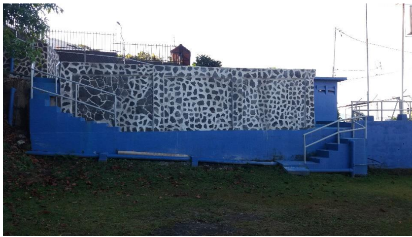
Tanque de almacenamiento La Amada.
