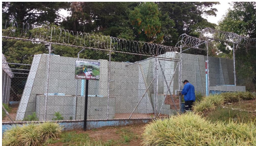
Tanque de almacenamiento Nel Ruíz 1 y 2.
