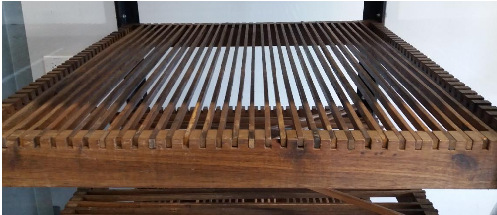
Figura 15. Detalle de las rejillas de la torre de enfriamiento de tiro inducido.
