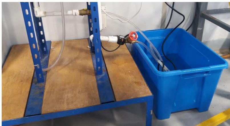
Figura 5. Depósito de agua de la torre de pared húmeda.
