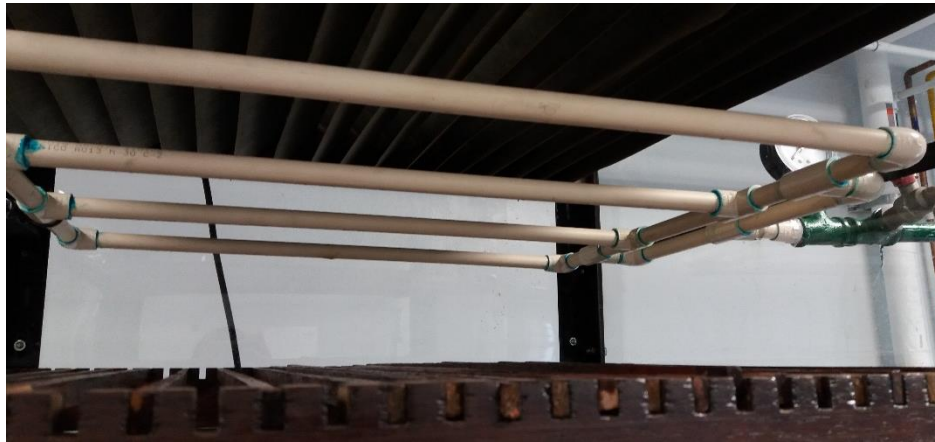
Figura 48. Rociador una vez colocado en la torre de enfriamiento.
