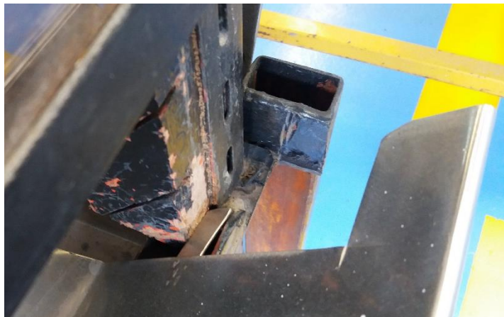
Figura 21. Detalle de la colocación de las paletas antiderrame.
