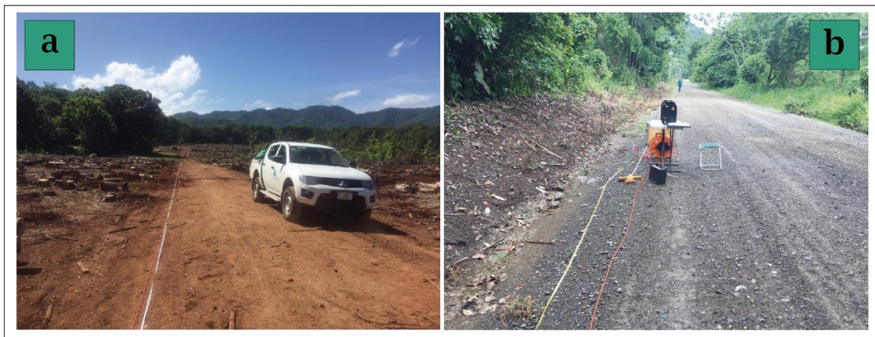
Figura 44. Tomografías eléctricas. (a): Tomografía C, (b): Tomografía E
