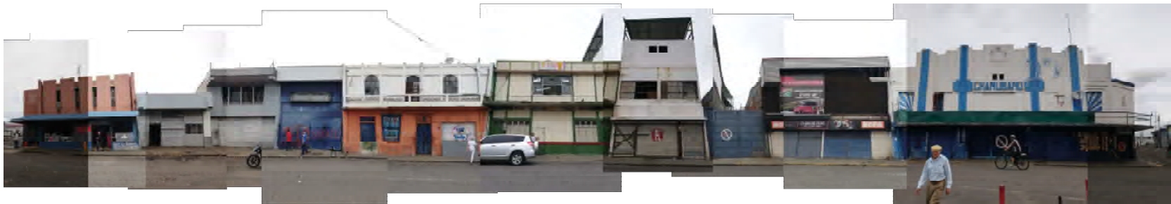
Imagen 31: Perfil Arquitectónico del entorno inmediato. Sección Calle 10 entre Ave 5 y 7. Vista hacia el Oeste
