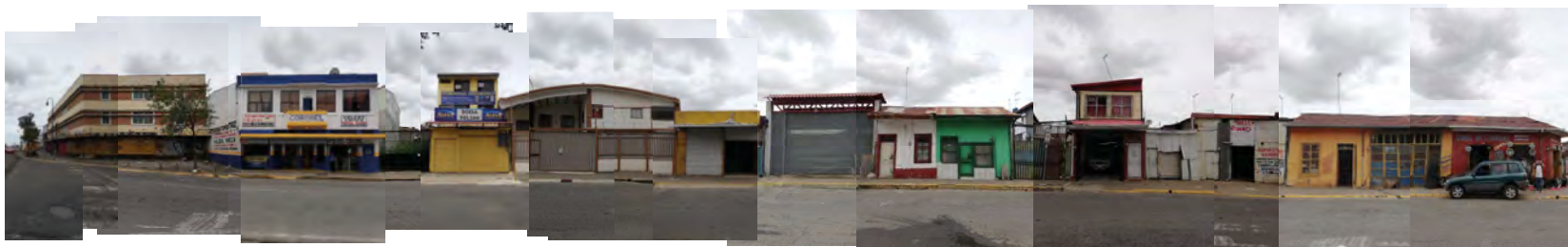
Imagen 32: Perfil Arquitectónico del entorno inmediato. Sección Calle 10 entre Ave 7 y 9. Vista hacia el Oeste
