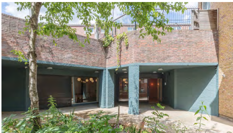
Imagen 54: Exterior nuevas instalaciones
