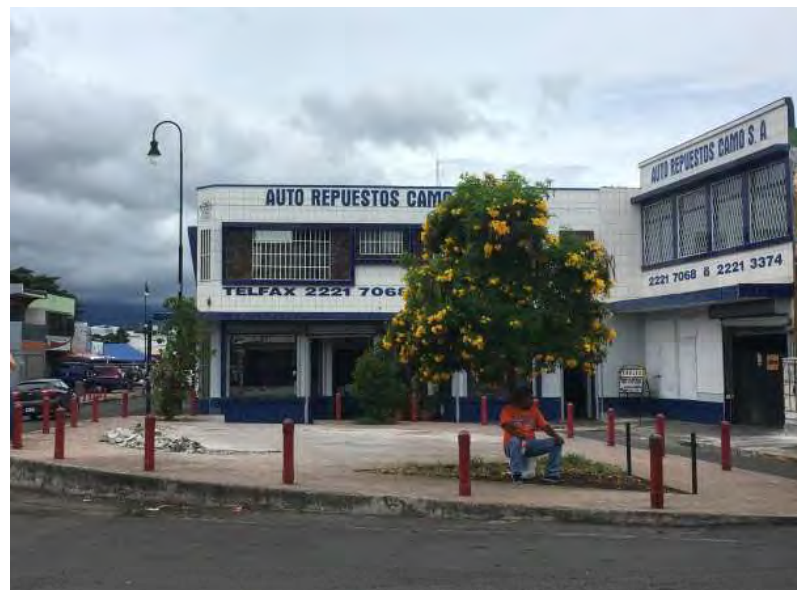
Imagen 28: Parque Líbano tras la demolición del mobiliario.
