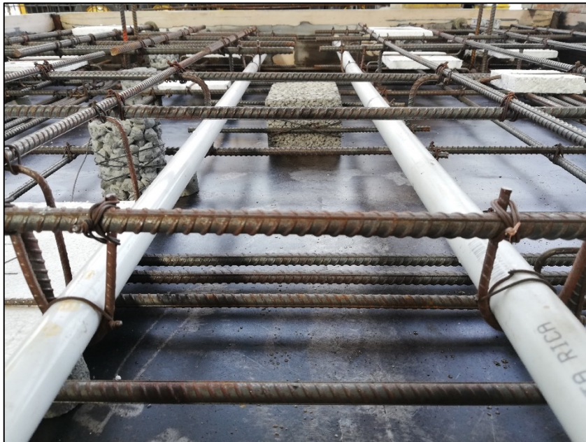
Figura 18. Colocación de tubería de PVC en la Losa 1
