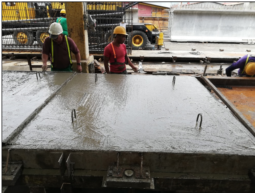
Figura 30. Acabado del concreto de la Losa 2
