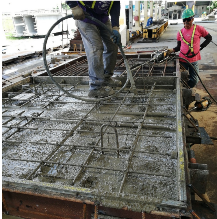
Figura 28. Vibrado del concreto en la Losa 1
