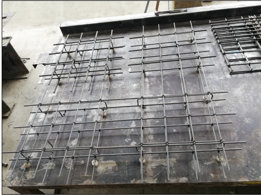
Figura 19. Detalle del acero de refuerzo de la Losa 1
