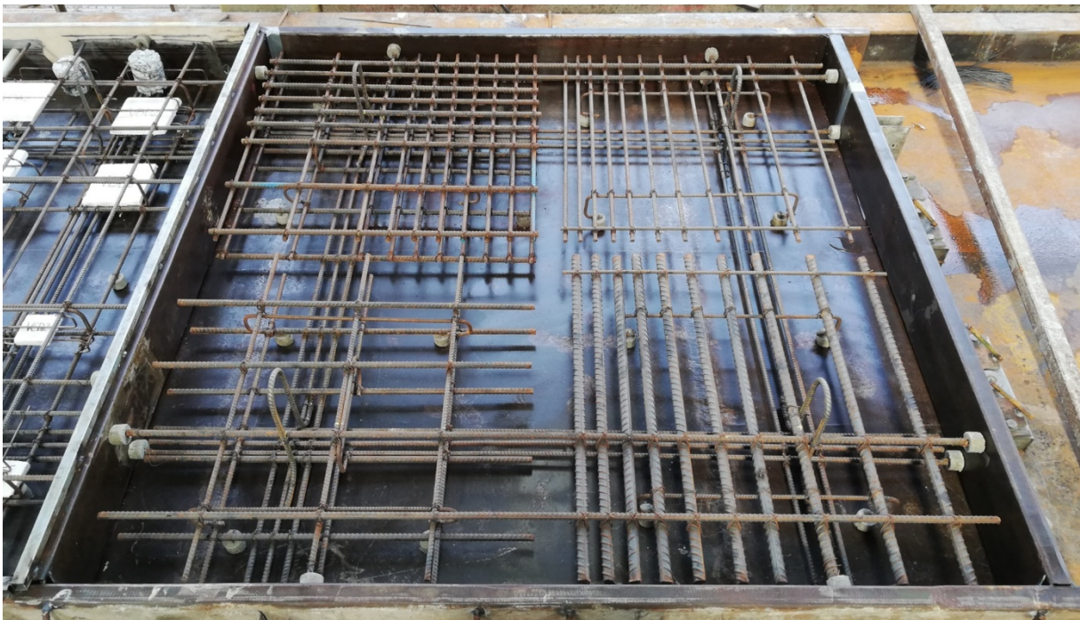
Figura 26. Colocación de la armadura en la formaleta de la Losa 2
