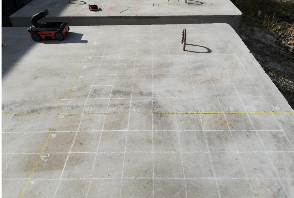
Figura 42. Detalle de la grilla demarcada sobre la losa 2
