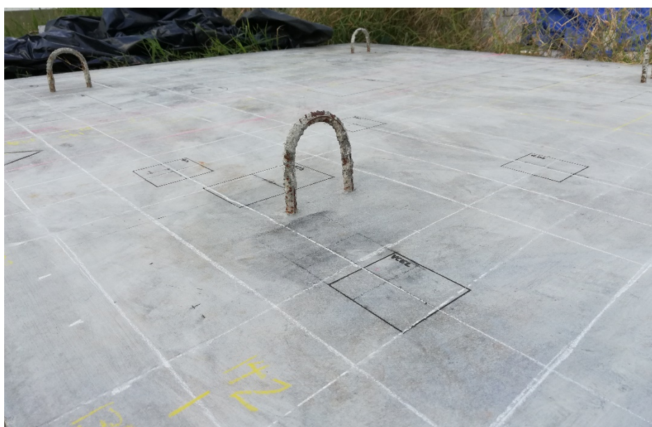
Figura 41. Detalle de la grilla demarcada sobre la losa 1
