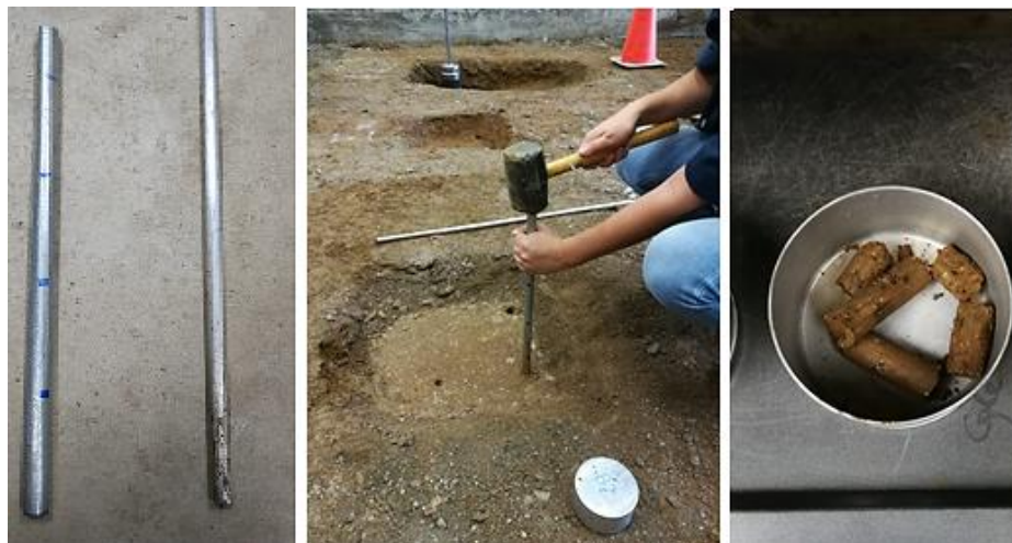
Figura 25. Toma de muestras de humedad de las calicatas
