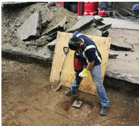
Figura 22. Construcción de calicatas y sustitución con suelo
