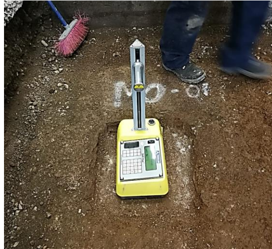
Figura 23. Verificación de compactación con densímetro
