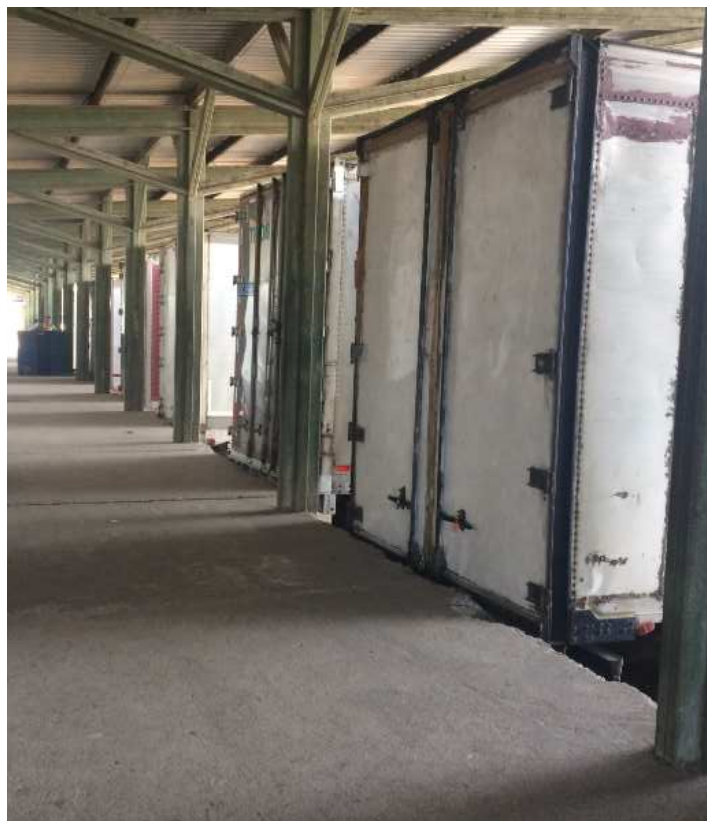
Anden para inspección física
