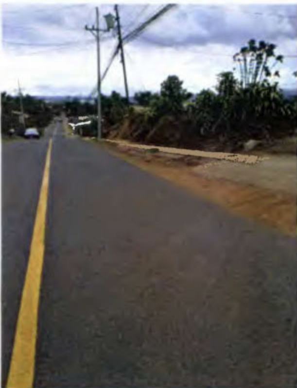
Aceras en construcción.
