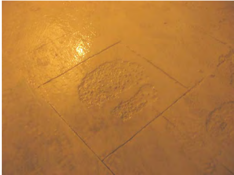
Fotografía 5.8. Paso 1. Delimitación de áreas críticas (26/08/05)
