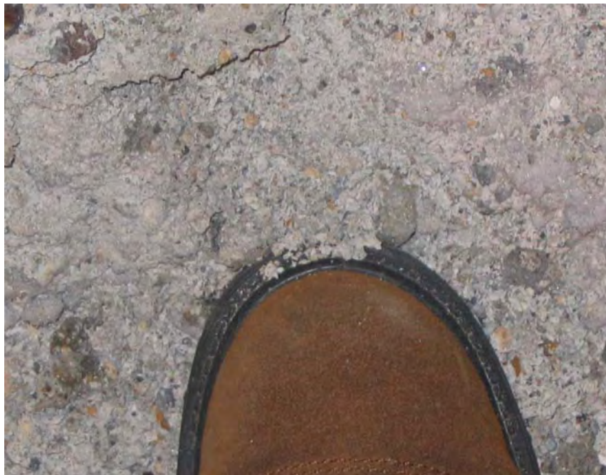
Fotografía 5.2. Concreto de la losa se destruye manualmente (04/07/05)
