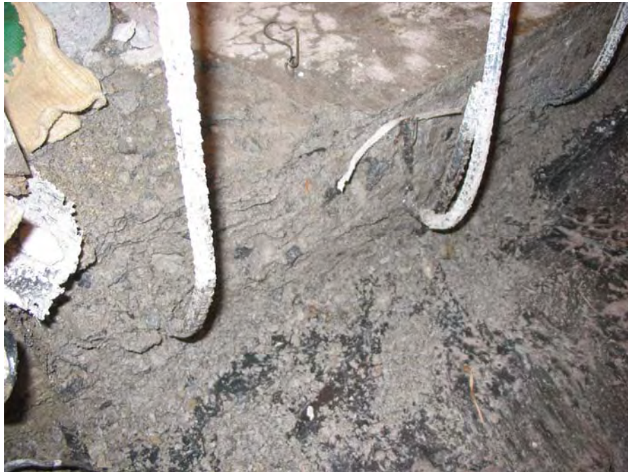
Fotografía 5.10. Paso 3. Superficie recién cortada (29/08/05)
