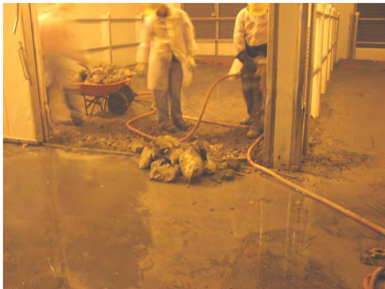
Fotografía 5.9. Paso 2. Remoción del concreto deteriorado (26/08/05)
