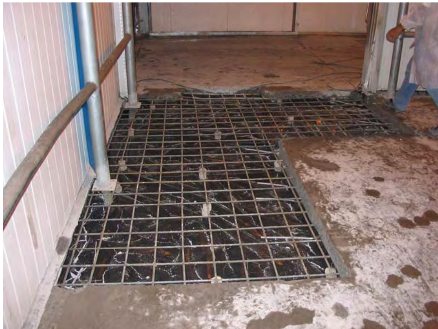
Fotografía 5.12. Paso 4. Colocación del refuerzo de reparación (30/08/05)
