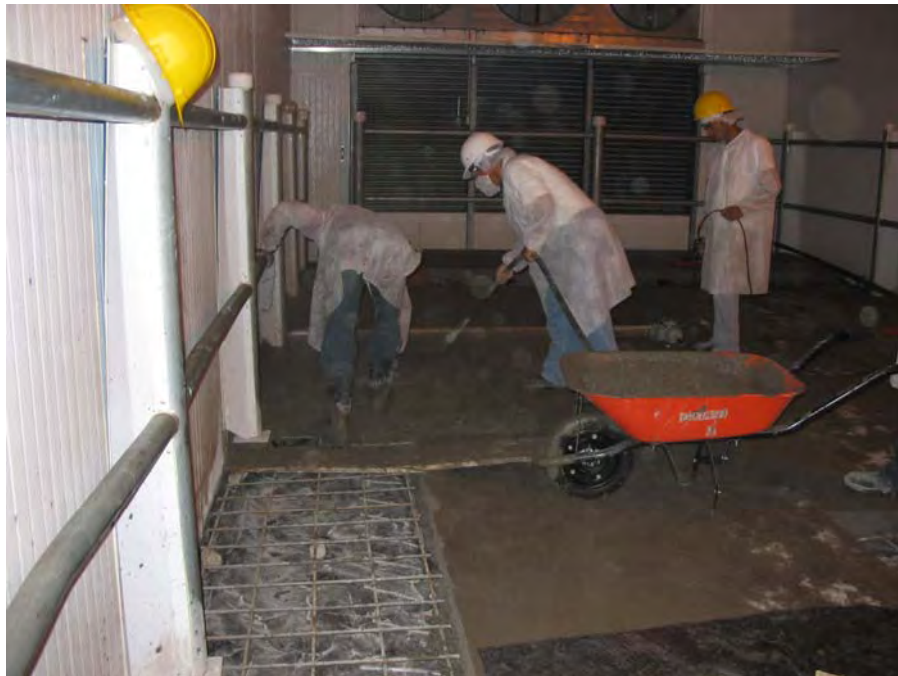
Fotografía 5.14. Paso 5. Colocación del concreto de reparación (31/08/05)
