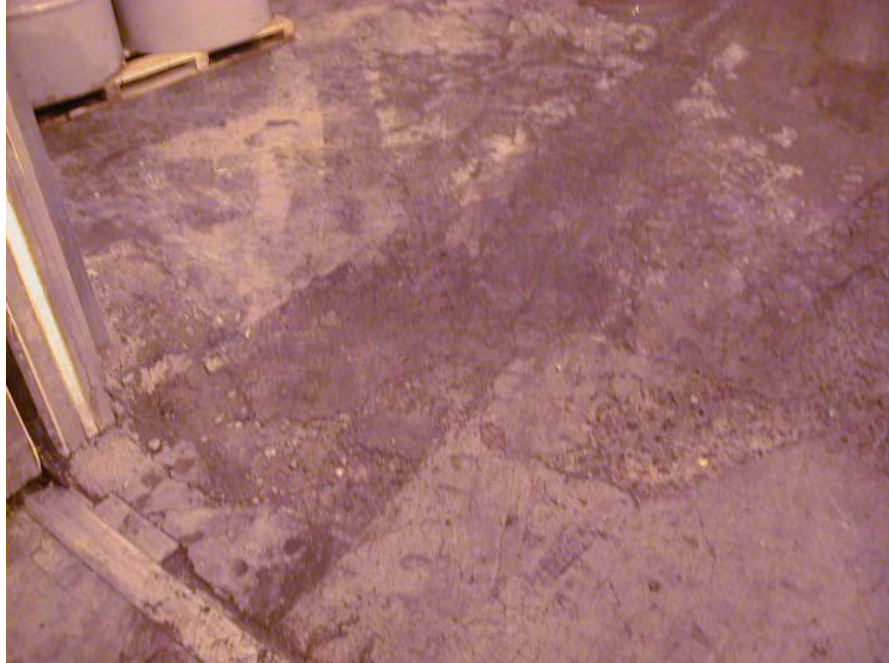
Fotografía 5.1. Zona de ingreso de montacargas (04/07/05)
