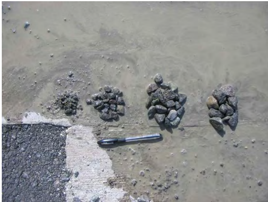
Fotografía 5.17. Inspección visual de agregados (31/08/05)
