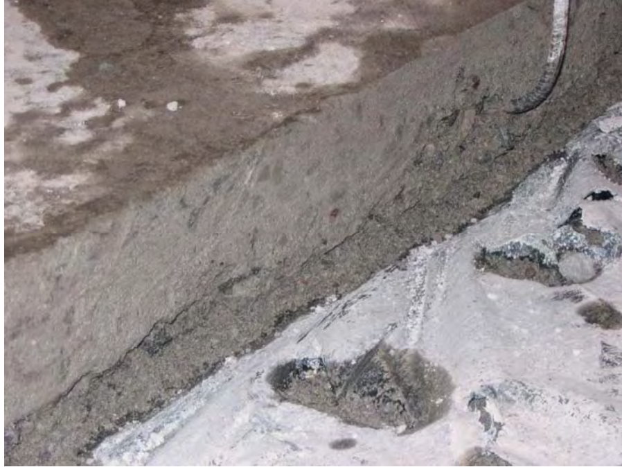
Fotografía 5.11. Paso 3. Limpieza de superficie (29/08/05)
