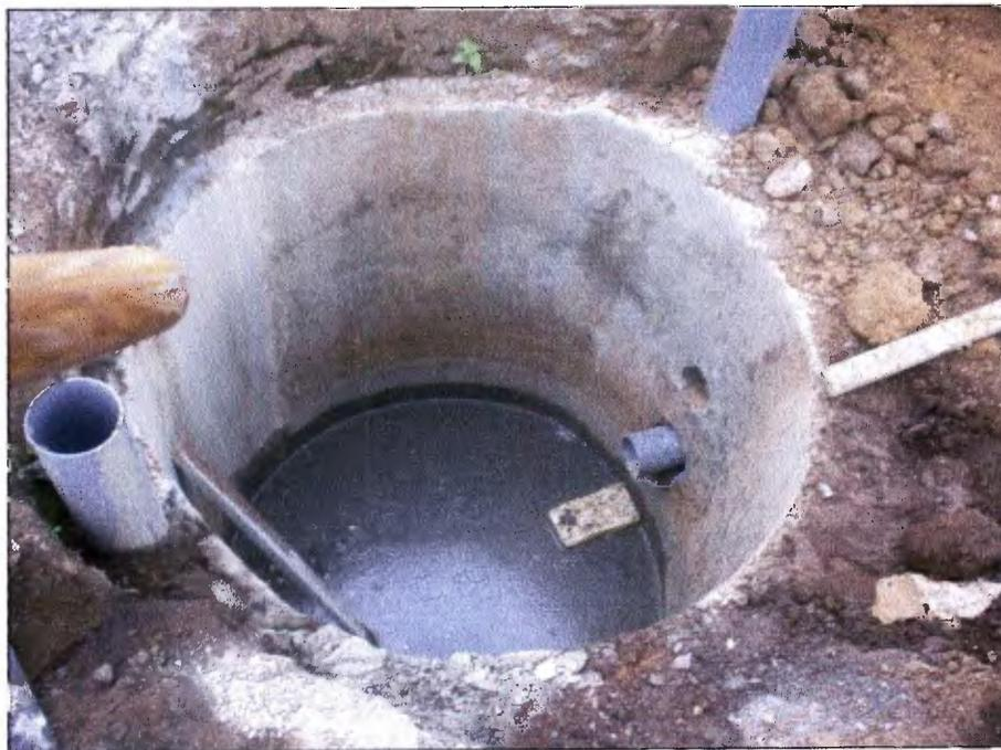
Figura Nº 19. Filtro Anaerobio en etapa de construcción.
