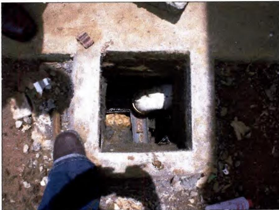
Figura N° 14. Sistema de distribución del Filtro Percolador
