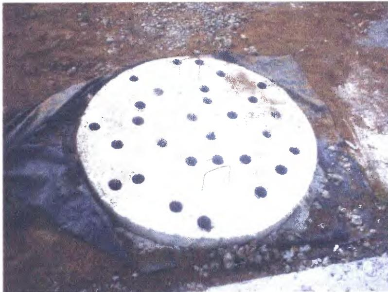
Figura N° 16. Fondo falso empleado en ambos filtros
