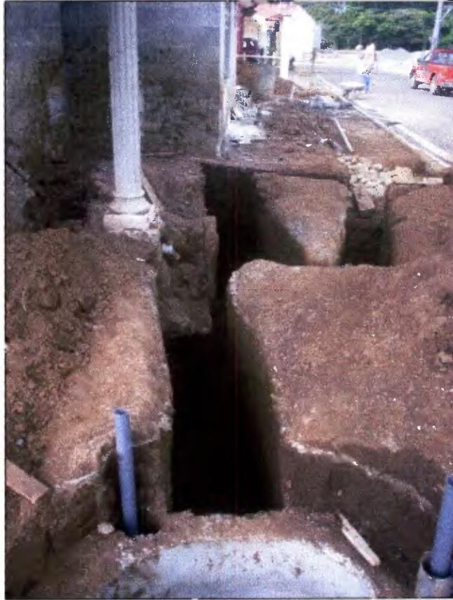
Figura N° 15. Drenaje en proceso constructivo
