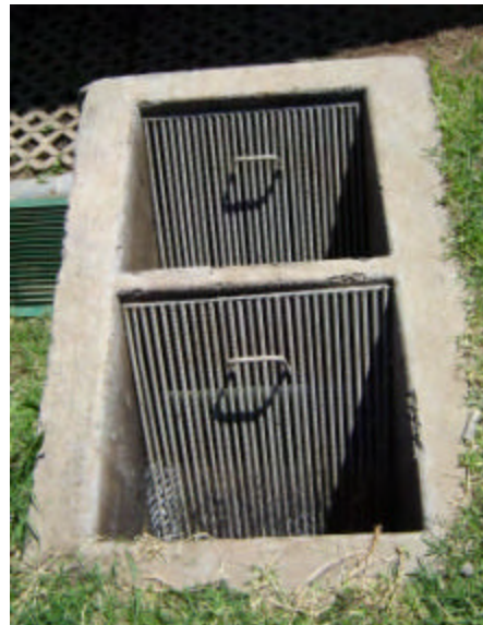
Fotografía 6-3: Cámara de entrada con rejillas en la PTAR de Bosques de Santa Ana
