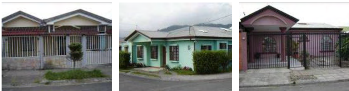
Fotografía 6-20: Casas de la urbanización Ciudad de Oro.
