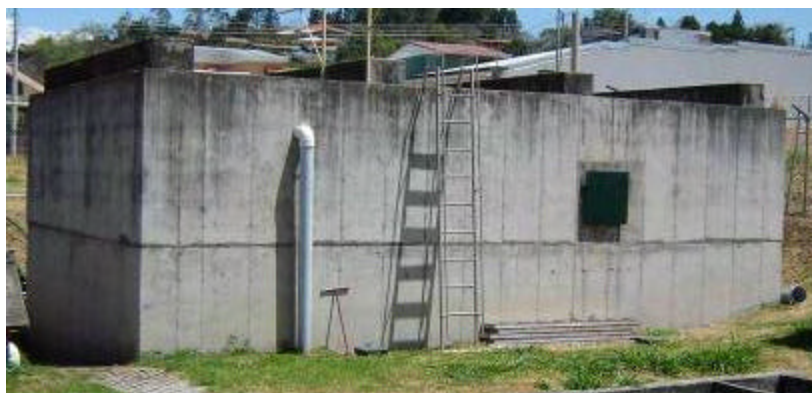
Fotografía 6-6: RAFA de la PTAR de Bosques de Santa Ana
