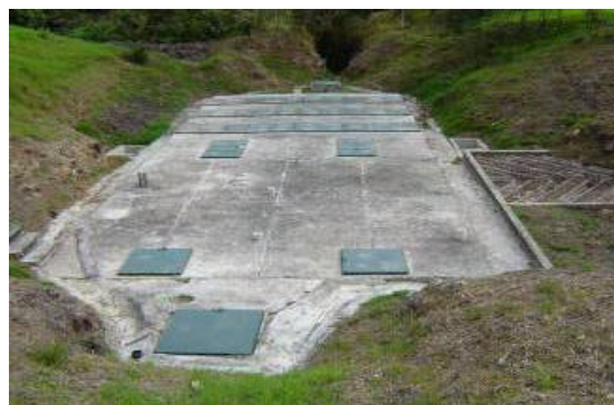
Fotografía 6-25: Vista general de la planta de tratamiento De Villas del Sol
