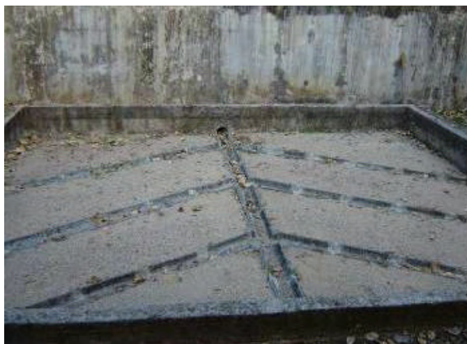
Fotografía 6-18: Lecho de secado, PTAR de Lomas de Curridabat.
