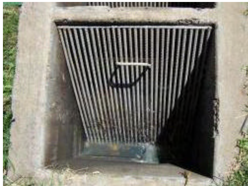
Fotografía 6-3: Cámara de entrada con rejillas en la PTAR de Bosques de Santa Ana
