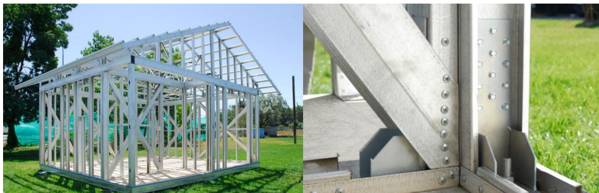
Figura 18. Sistema Steel Frame Fuente: Plataforma Arquitectura (s.f.)
