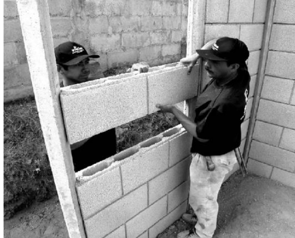
Figura 35. Sistema constructivo Blocon Fuente: Castañeda, 2005
