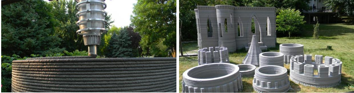
Figura 36. Construcción 3D Fuente: Contreras, 2016
