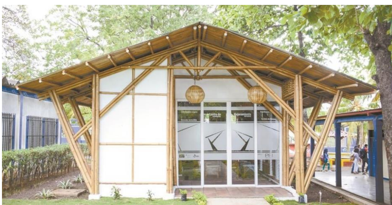
Figura 30. Sistema constructivo en bambú Fuente: Gonzales, 2018
