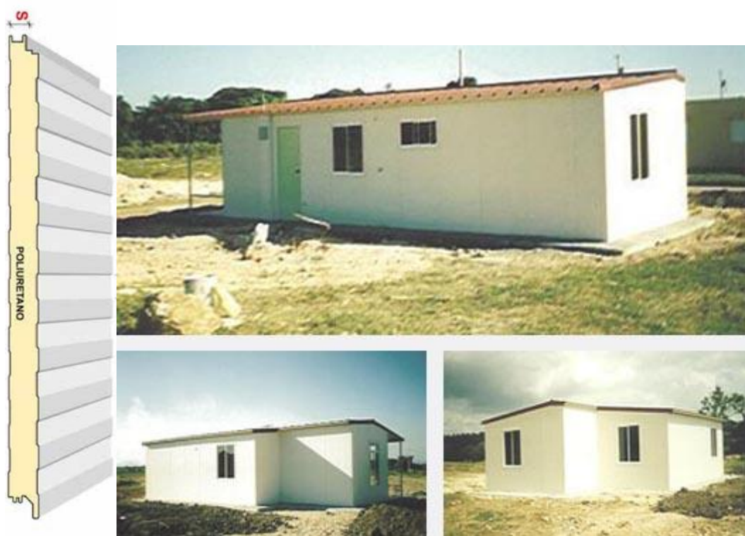
Figura 15. Sistema emparedado con núcleo de poliuretano y bordes de acero Fuente: Metecno, 2012
