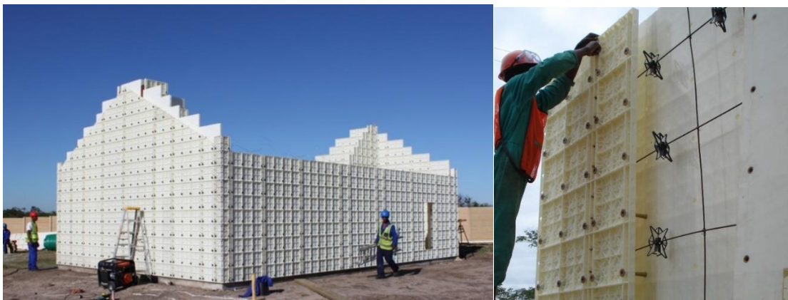
Figura 32. Sistema constructivo Moladi Fuente: Valencia, 2015
