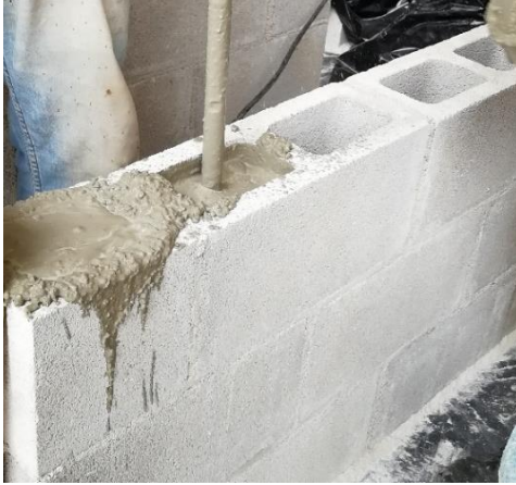
Figura 18. Colocación del concreto de relleno en los muretes
