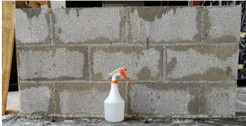
Figura 17. Aspersor de agua utilizado para curar las juntas de mortero
