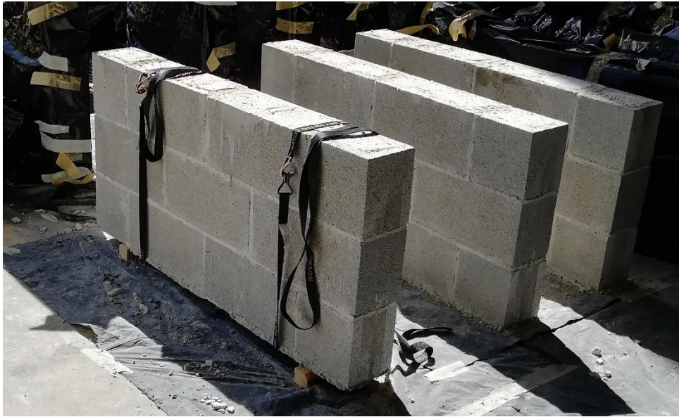
Figura 22. Colocación de piezas de madera y eslingas
