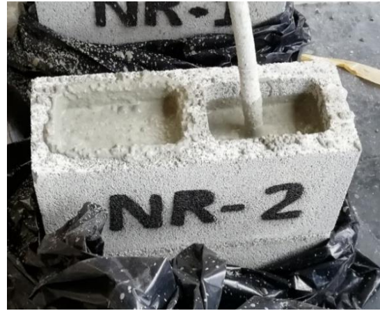
Figura 19. Colocación del concreto de relleno en los prismas
