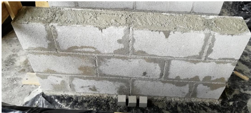
Figura 16. Curado de los cubos de mortero para el control de calidad
