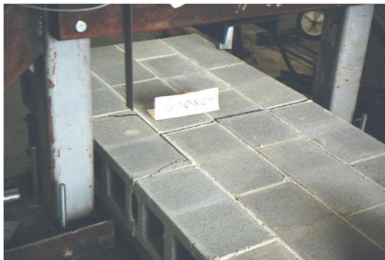
Figura 2. Tipo de fractura presentada en la investigación Flexural Bond Strength of Masonry Parallel to the Bed Joints
