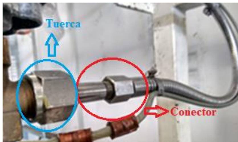
Figuras 5.4.2. Conector de acero inoxidable en la manguera de un “cilindros madre” del panel de trasvase.
