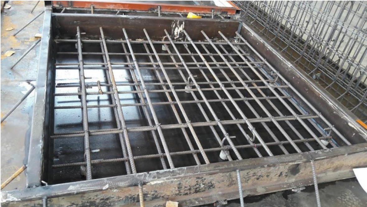
Figura 11. Formaleta y armadura de la Losa 1
