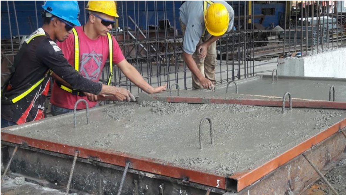
Figura 21. Proceso de acabado de la superficie en ambas losas
