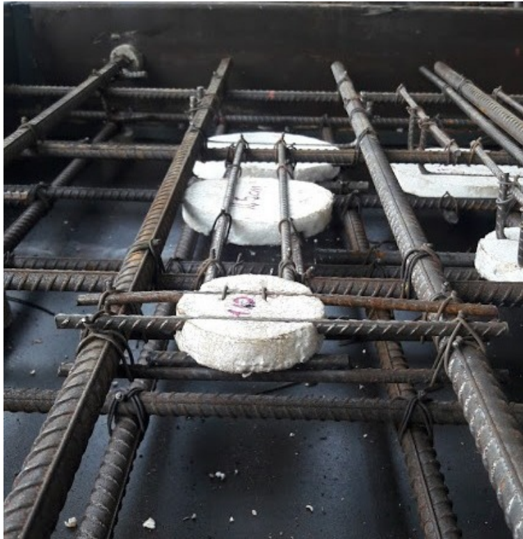
Figura 14. Fijación de los discos de poliestireno por medio de varilla y alambre de acero
