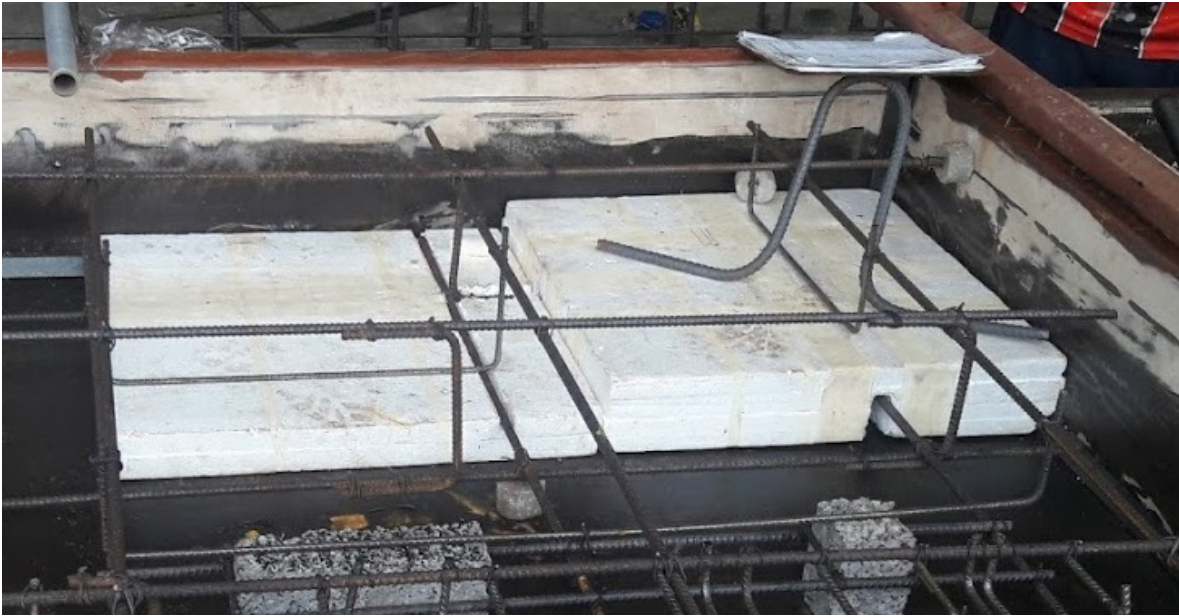
Figura 16. Fijación de los bloques de poliestireno por medio de varilla y alambre de acero
