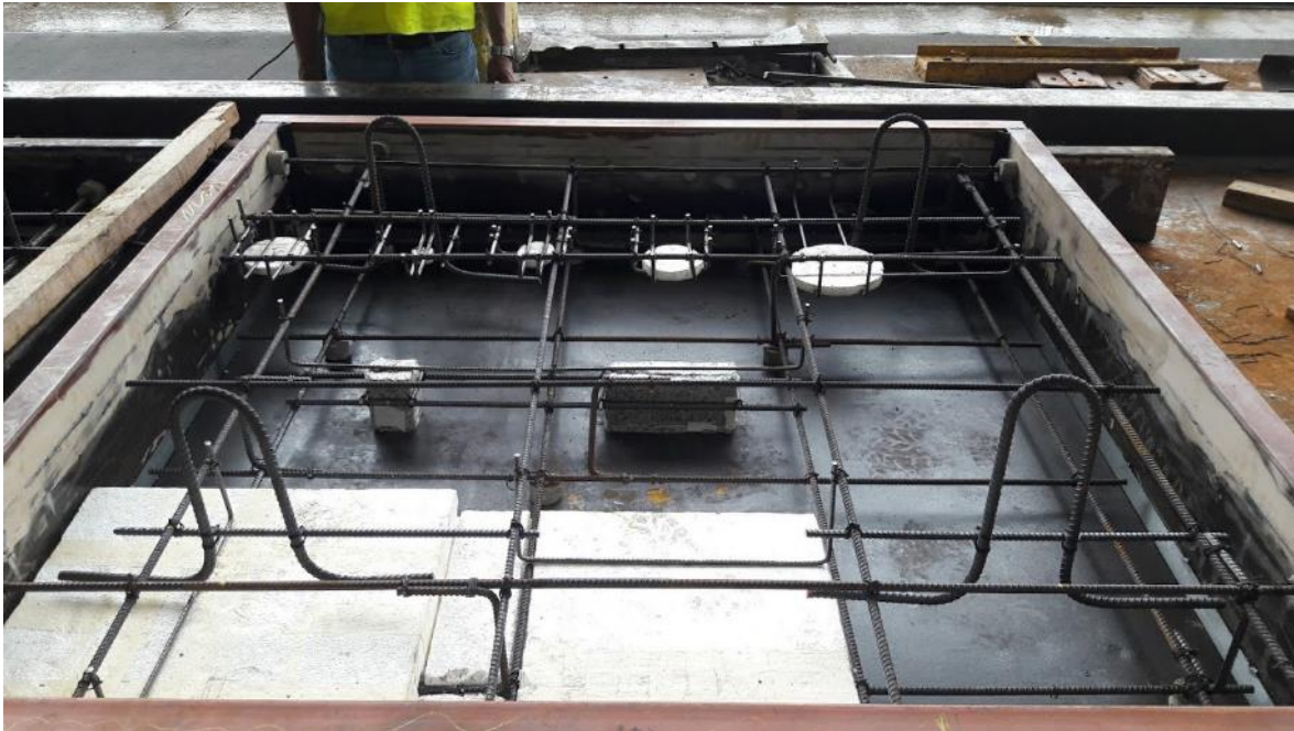
Figura 18. Totalidad de los defectos instalados en la Losa 2 previo a la colocación del concreto
