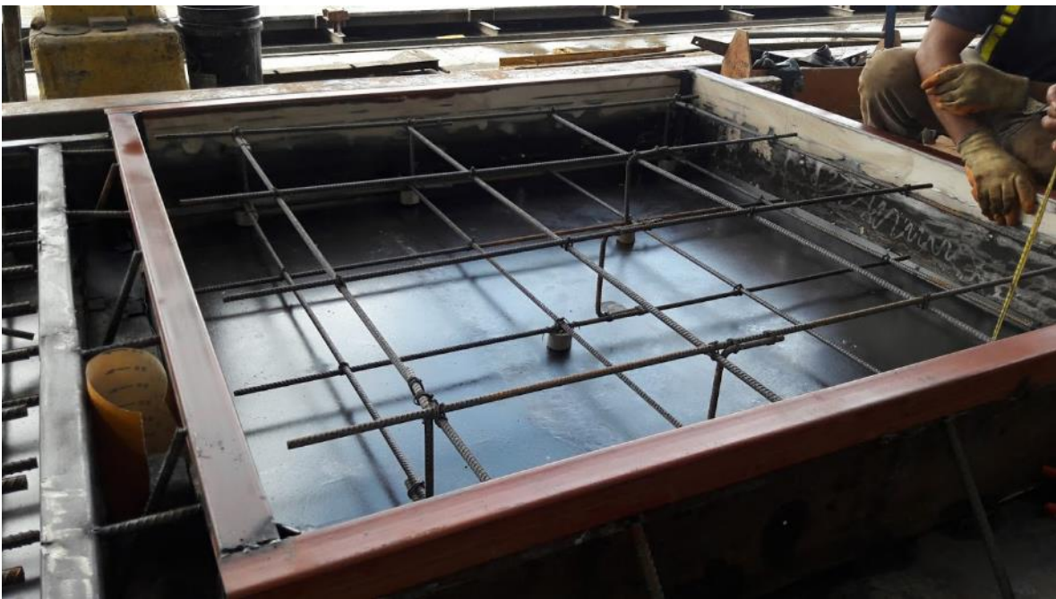
Figura 12. Formaleta y armadura de la Losa 2
