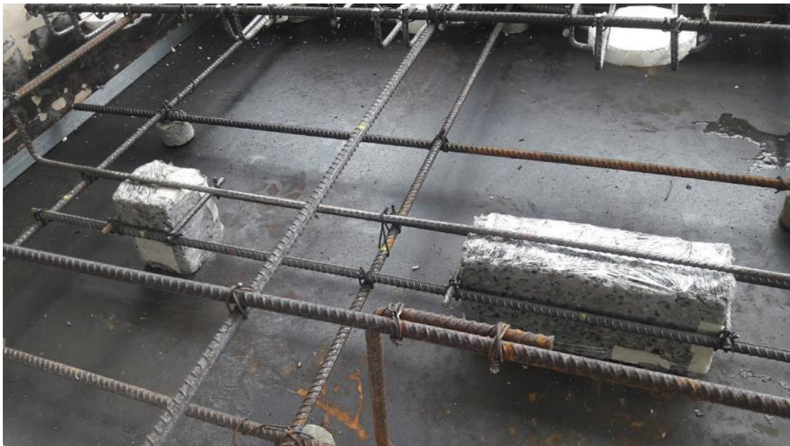
Figura 15. Fijación de los bloques de concreto permeable por medio de varilla y alambre de acero
