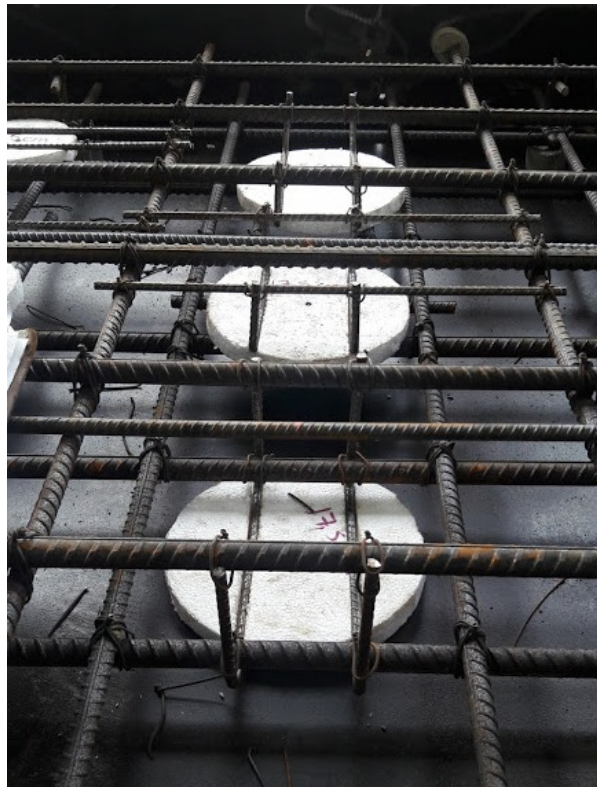
Figura 13. Fijación de los discos de poliestireno por medio de varilla y alambre de acero
