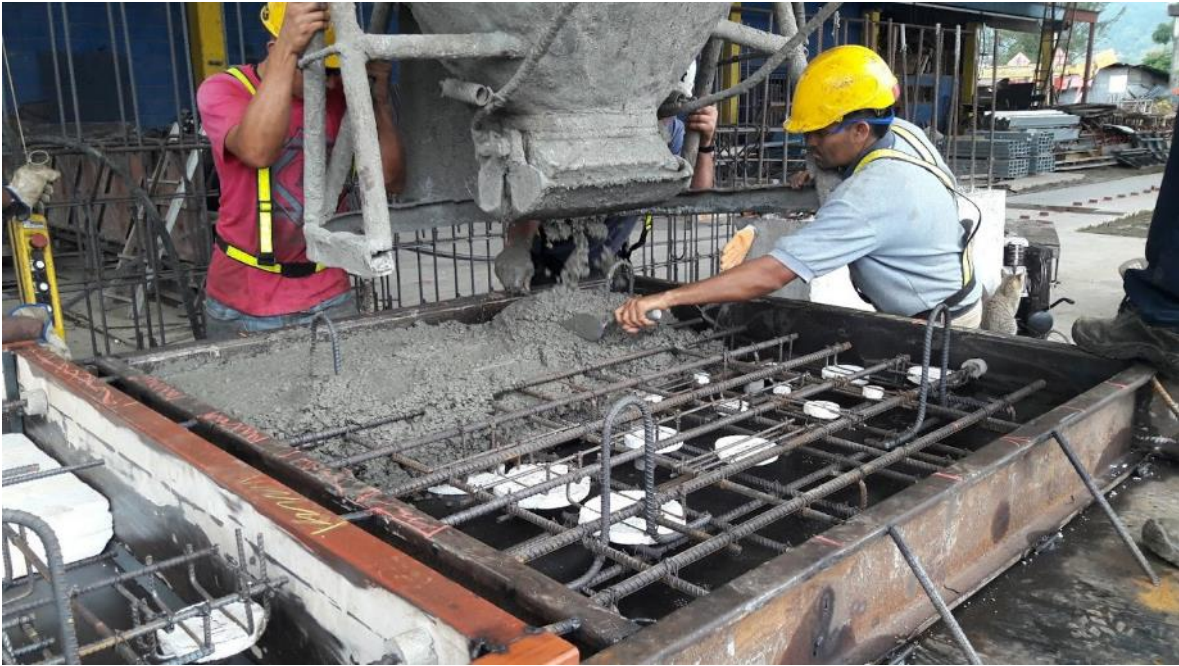
Figura 19. Proceso de colocación del concreto en la Losa 1
