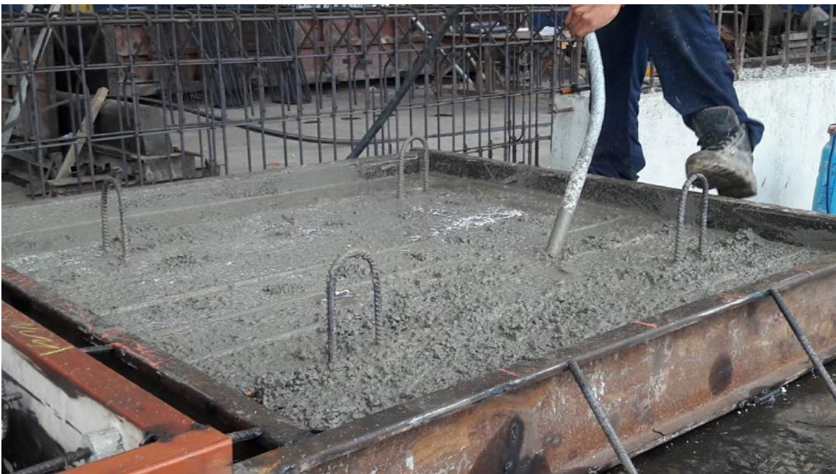
Figura 20. Vibrado del concreto en la Losa 1
