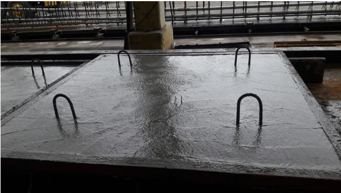
Figura 22. Acabado final de la Losa 2
