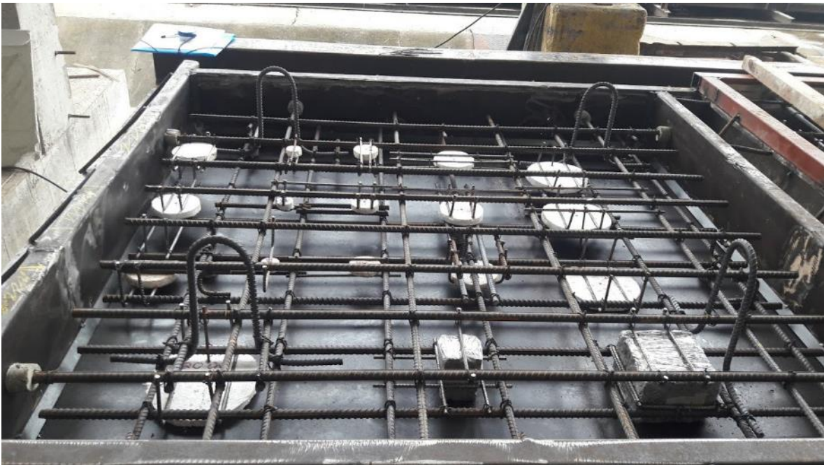
Figura 17. Totalidad de los defectos instalados en la Losa 1 previo a la colocación del concreto
