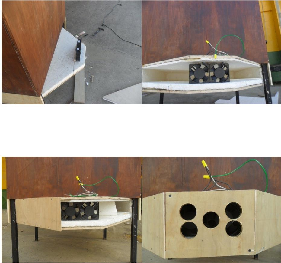
**Figura 4.2.** Cámara de secado en su etapa de construcción. Fuente: Julián Molina
