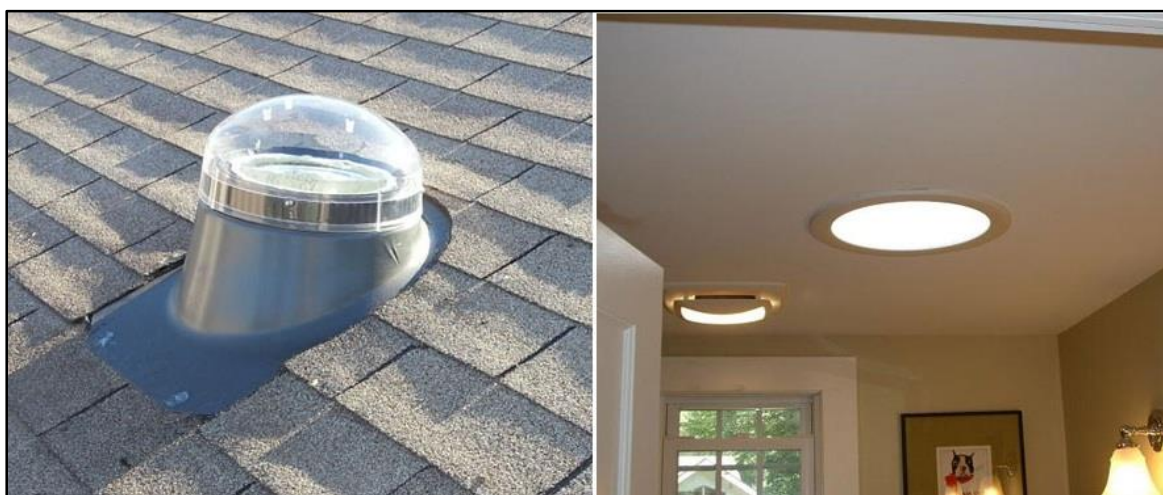
Figura 4. 2. Implementación de lumiductos
