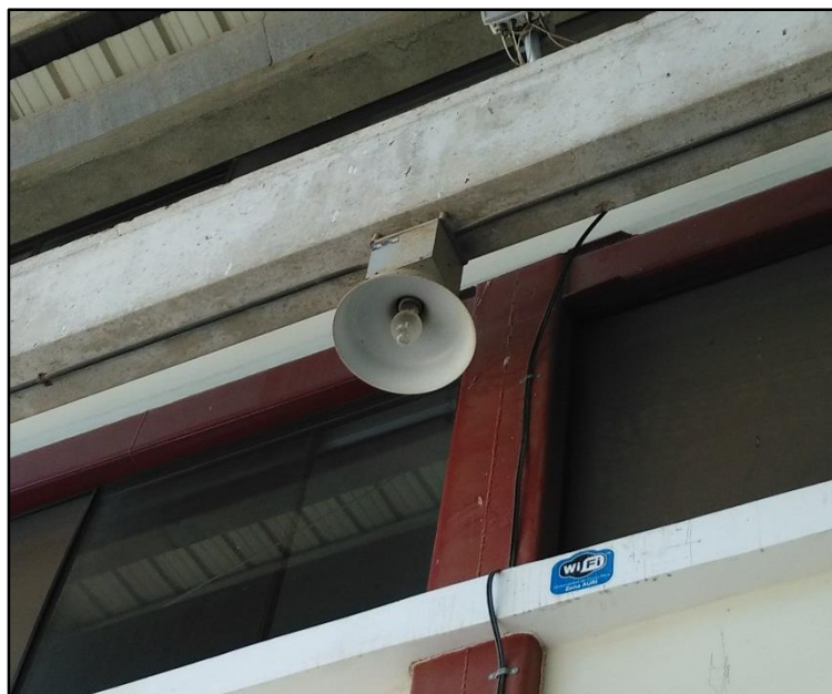
Figura 3. 6. Lámparas de mercurio del edificio del LanammeUCR
