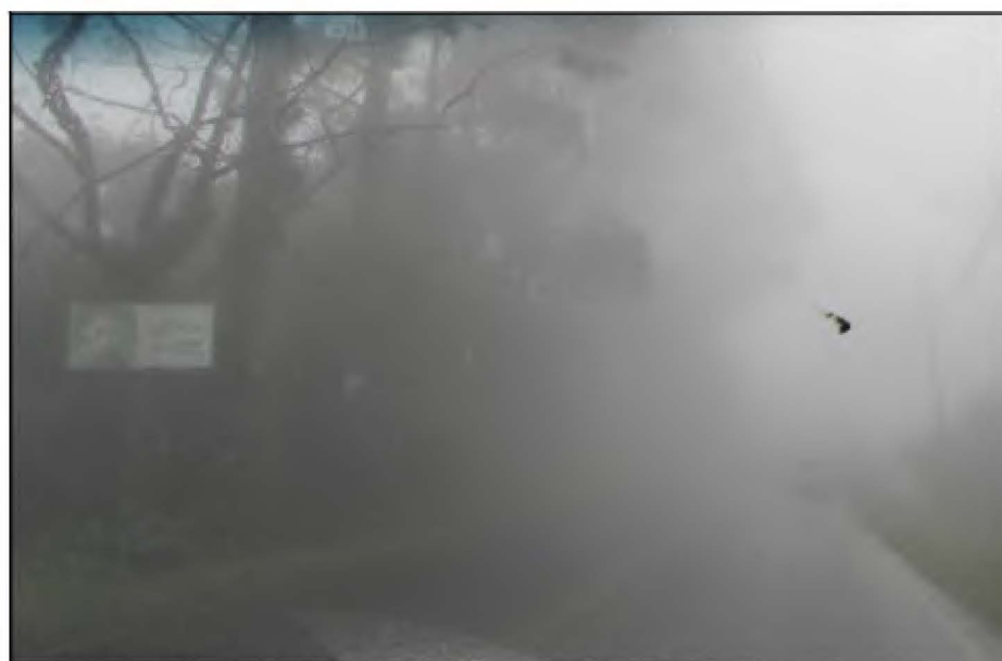
Figura 6.13. Poca visibilidad en el tramo 13 (Mayo, 2015)
