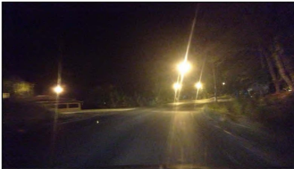
Figura 6.68. Poca visibilidad en el tramo 121 (Noviembre, 2015)
