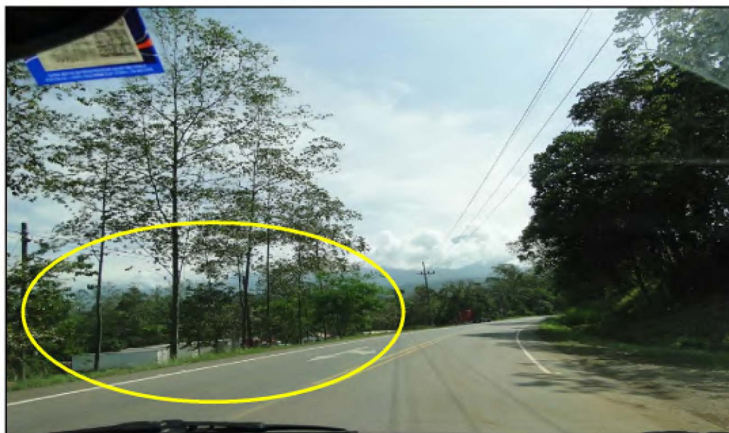
Figura 6.132. Ausencia de sistema de contención en el tramo 124
