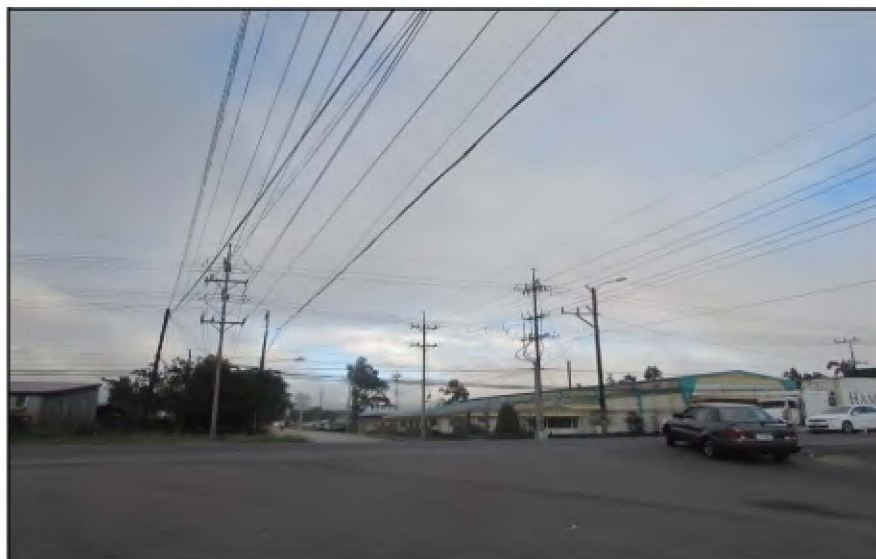
Figura 6.79. Señalización inexistente en la intersección Megasuper El Guarco
