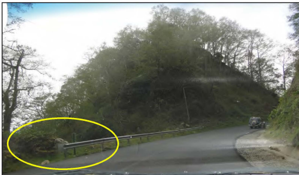
Figura 6.128. Terminal cola de pez en el tramo 47
