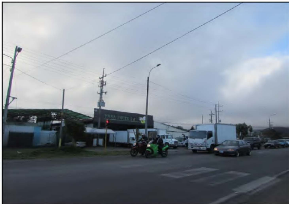
Figura 6.85. Señalización borrosa (Enero, 2016)
