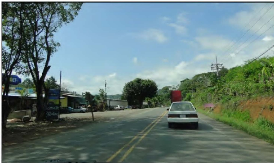
Figura 6.67. Accesos a lo largo del tramo 121 (Mayo, 2015)
