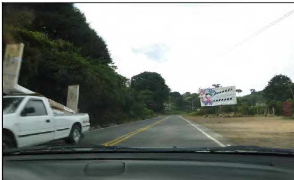
Figura 6.17. Recta en el tramo 27 El Empalme (Mayo, 2015)
