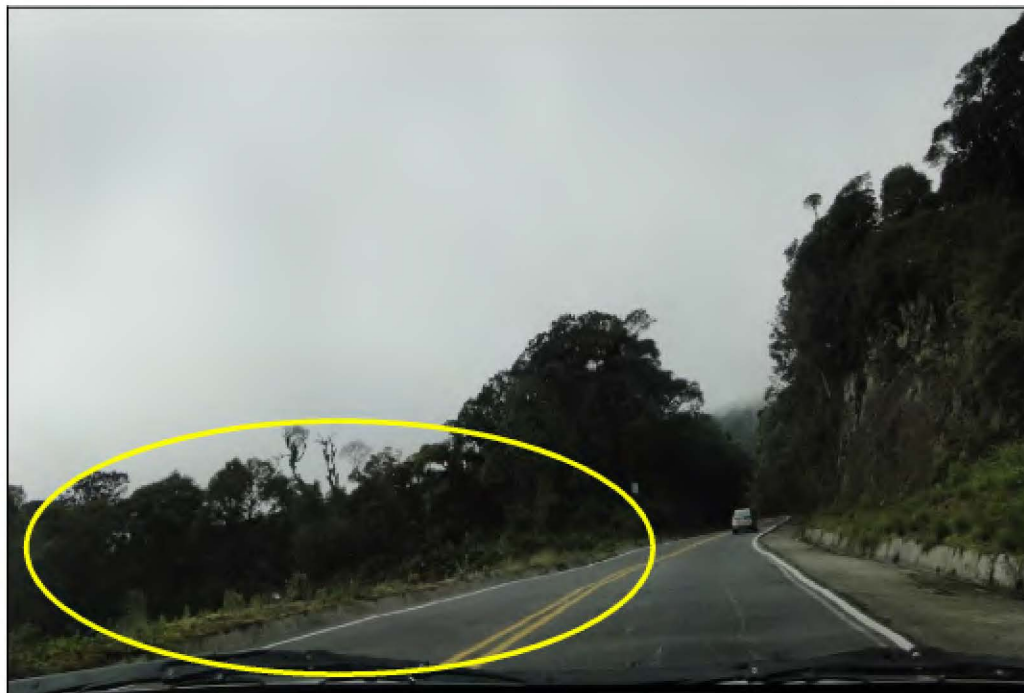
Figura 6.127. Sección del tramo 46 sin barreras de contención
