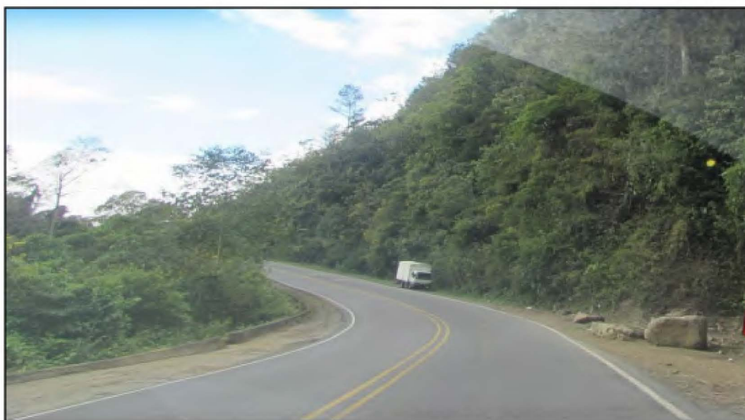
Figura 6.38. Presencia de rocas en los márgenes del tramo 95 (Mayo, 2015)
