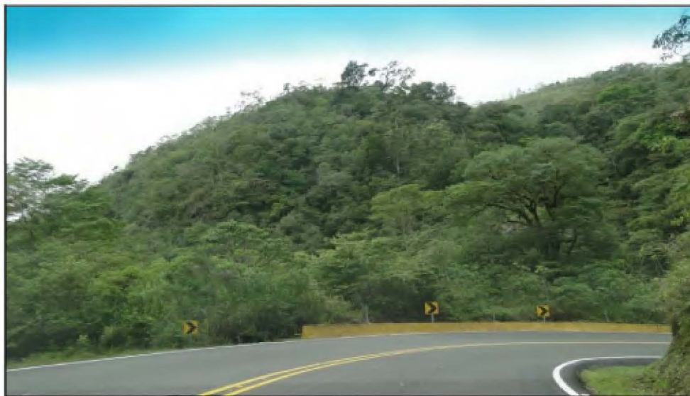
Figura 6.39. Barrera de concreto en el tramo 95 (Mayo, 2015)
