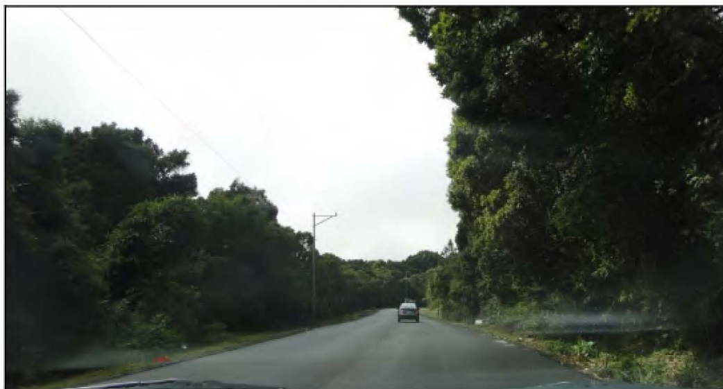
Figura 4.5. Fotografía de un tramo con alineamiento recto (Mayo, 2015)
