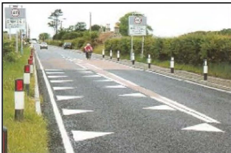
Figura 6.62. Ejemplo de umbral para medidas de tráfico calmado
