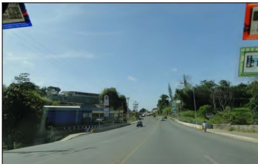
Figura 6.45. Señalización deficiente en el tramo 110 (Mayo, 2015)
