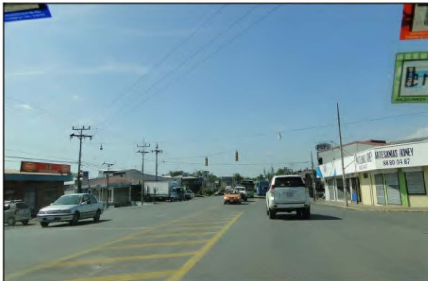
Figura 6.44. Carriles de giro en el tramo 110 (Mayo, 2015)
