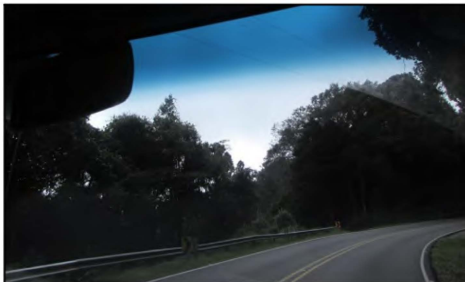
Figura 6.26. Barrera metálica en una curva del tramo 73
