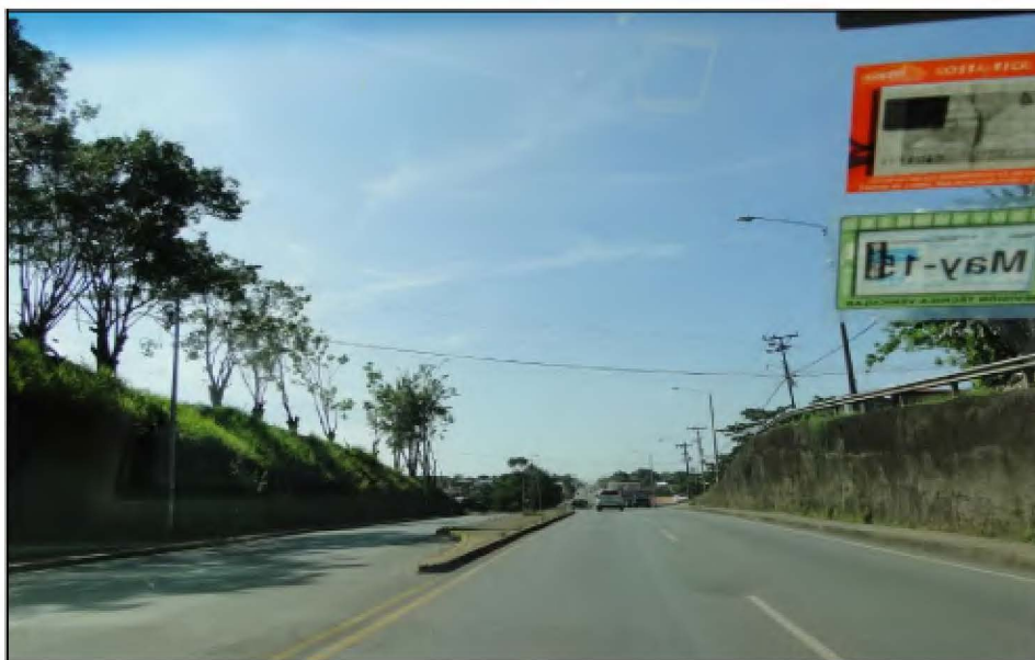
Figura 6.50. Isla de concreto en el tramo 111 (Mayo, 2015)
