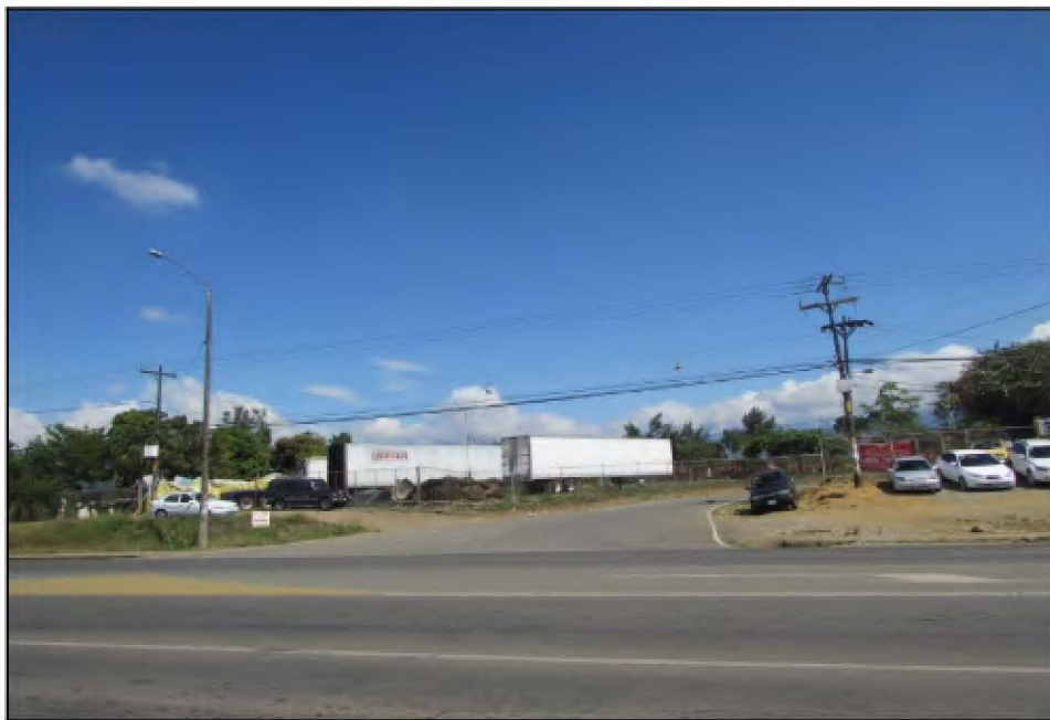
Figura 6.113. Señalización horizontal borrosa en el cruce Barrio Lourdes (Enero, 2016)
