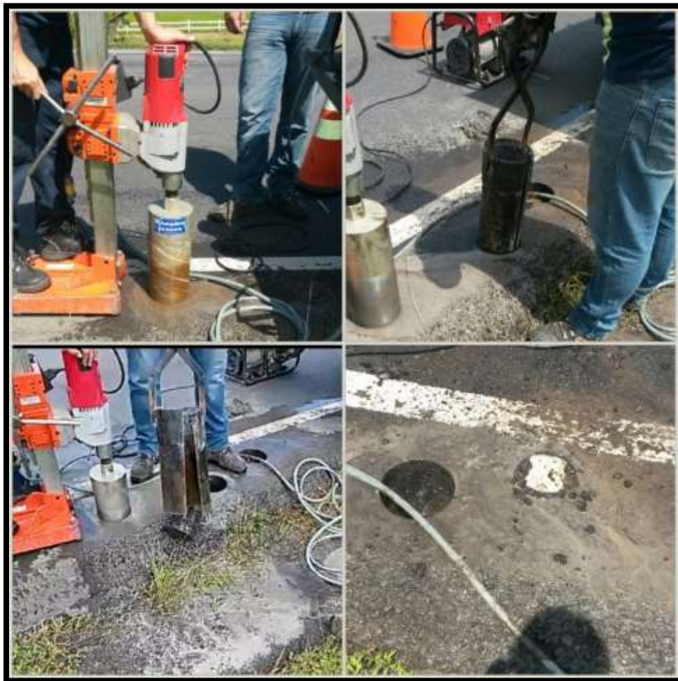
Figura 22. Proceso de extracción de núcleos en la Ruta Nacional 32
