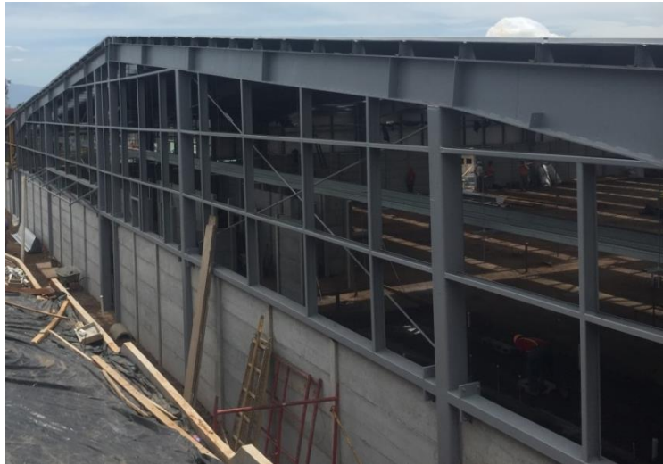
Figura 3.15. Instalación de tensores de pared transversales proyecto en Puriscal, San José
