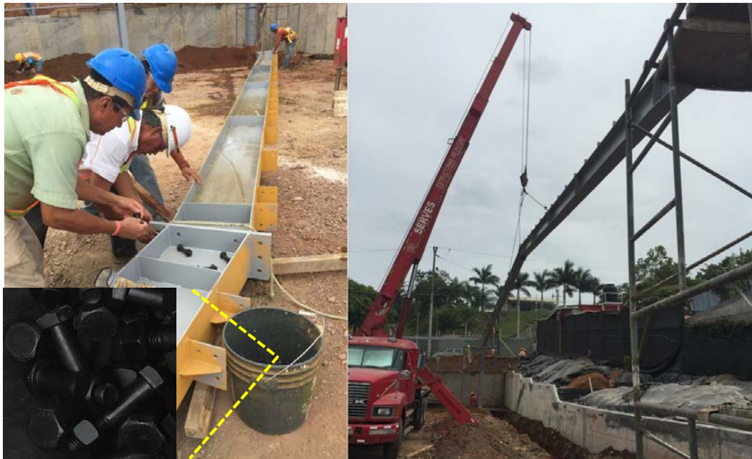
Figura 3.6. Colocación de vigas principales proyecto en Puriscal, San José
