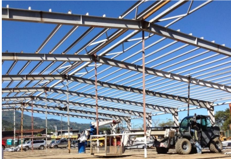
Figura 5.1 Apuntalamiento en marcos de prototipo soldado en Desamparados, San José Costa Rica
