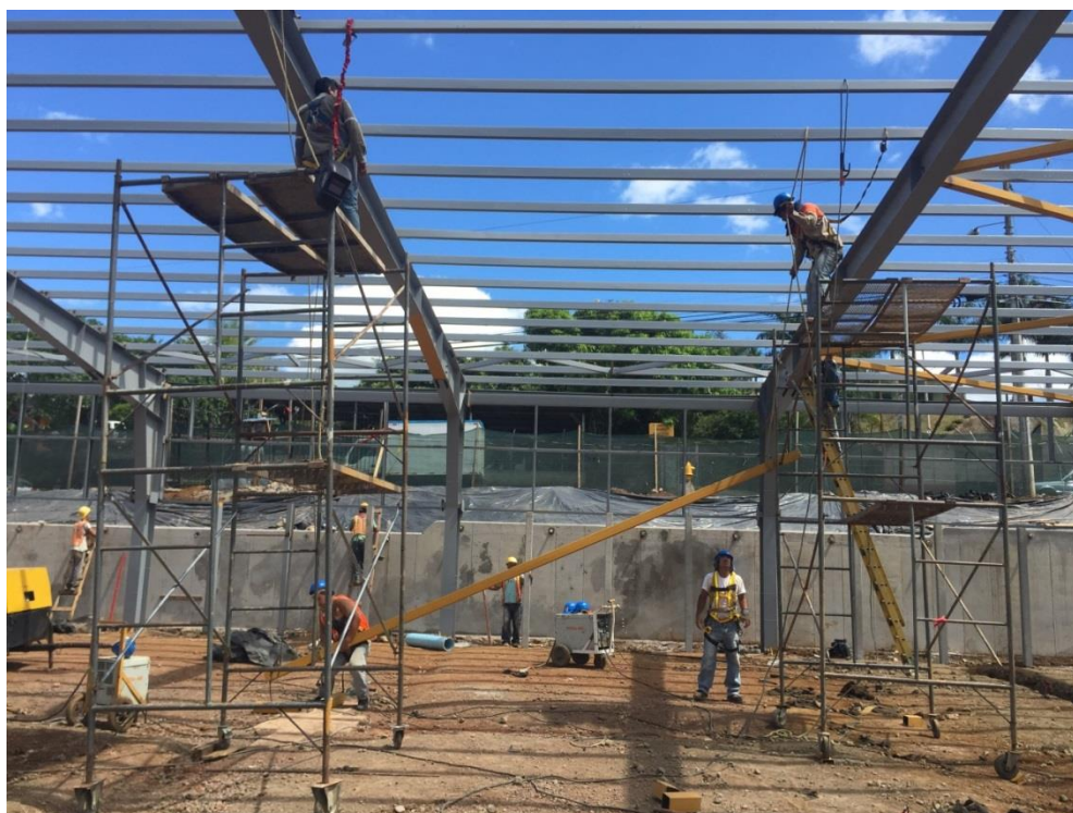
Figura 5.4 Instalación de tensores de techo en tubo
