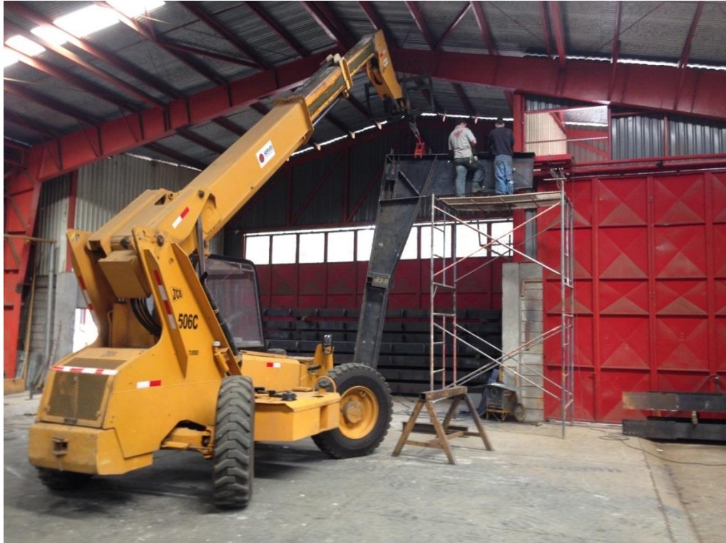
Figura 3.1. Presentación de la pieza tipo columna en estructura con conexiones pernadas
