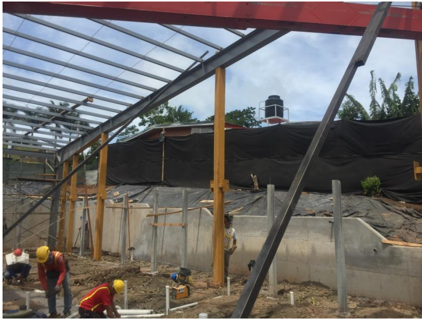
Figura 3.12. Instalación de columnas secundarias proyecto en Puriscal, San José
