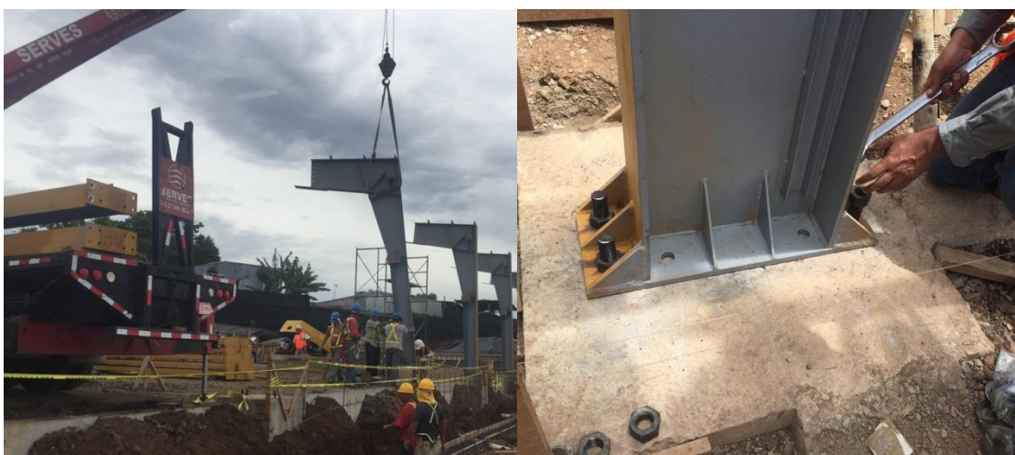
Figura 3.4. Instalación de columnas principales proyecto en Puriscal, San José
