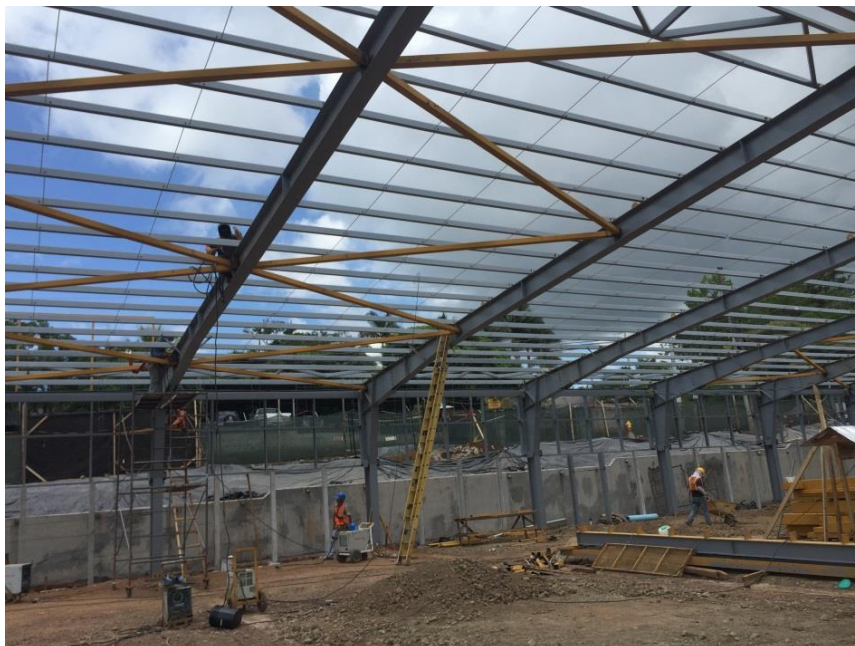
Figura 3.8. Instalación de tensores de techo proyecto en Puriscal, San José
