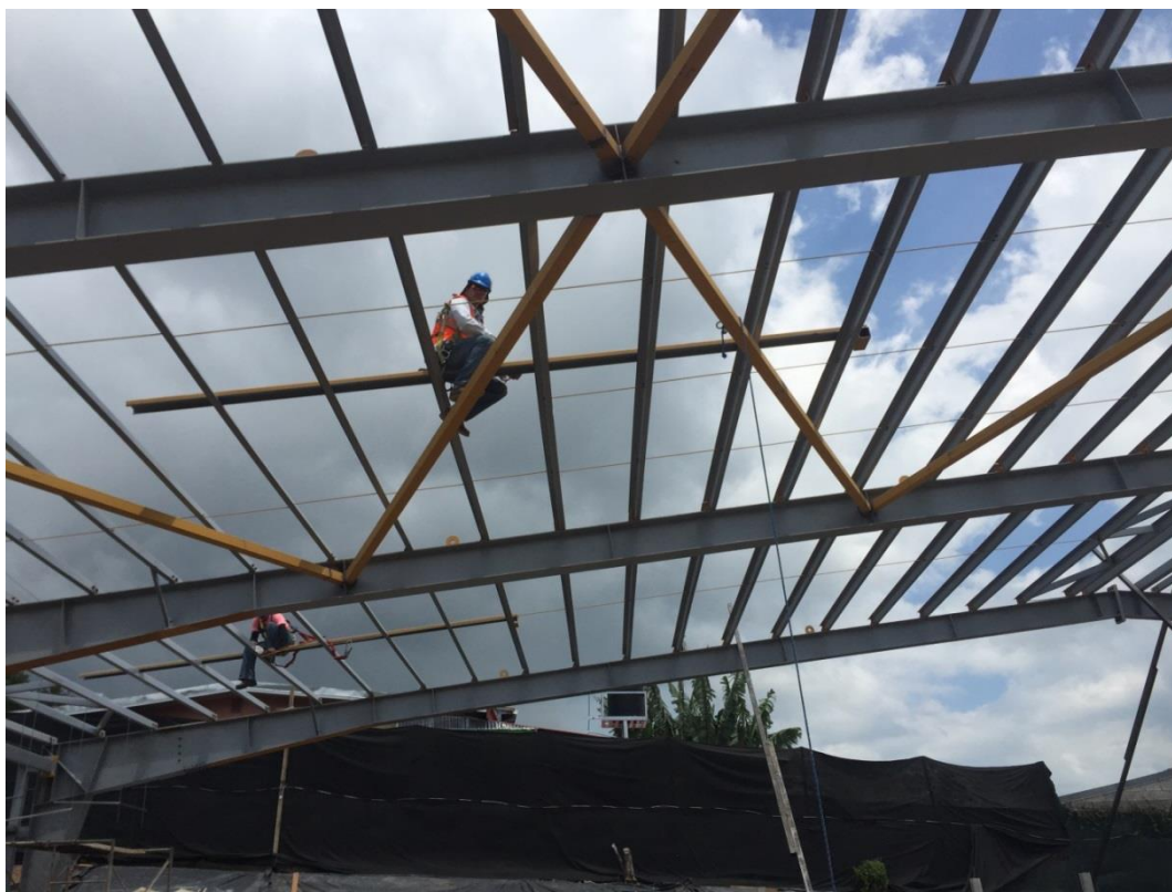
Figura 5.5 Instalación de cinchas entre clavadores
