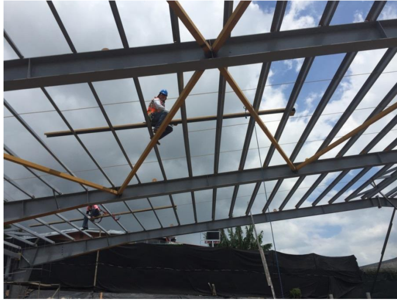
Figura 3.10. Instalación de cinchas entre clavadores proyecto en Puriscal, San José
