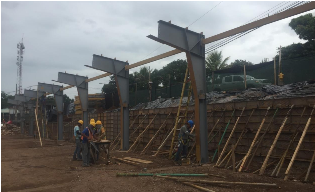
Figura 3.5. Instalación de vigas de amarre superiores proyecto en Puriscal, San José
