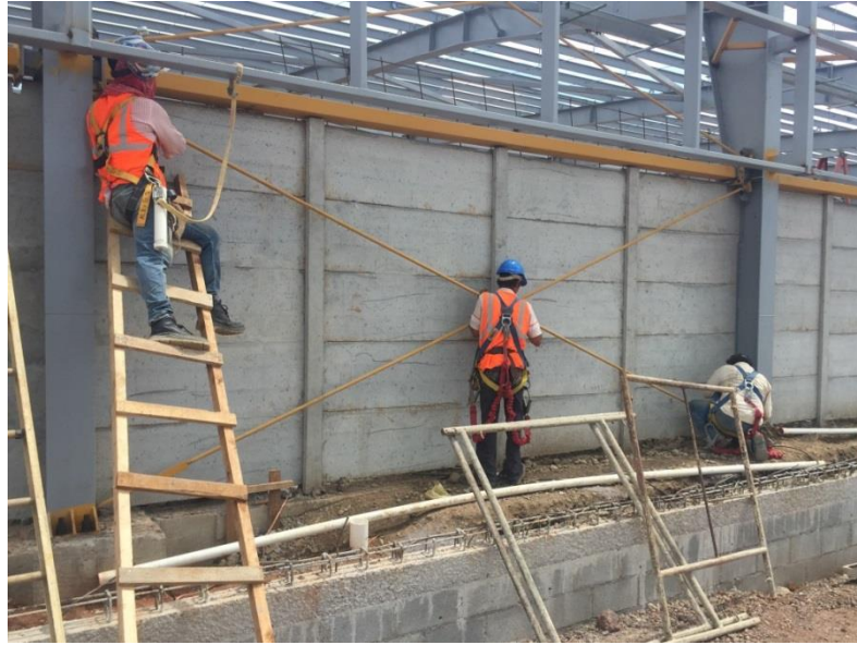
Figura 3.13. Instalación de tensores de pared longitudinales proyecto en Puriscal, San José
