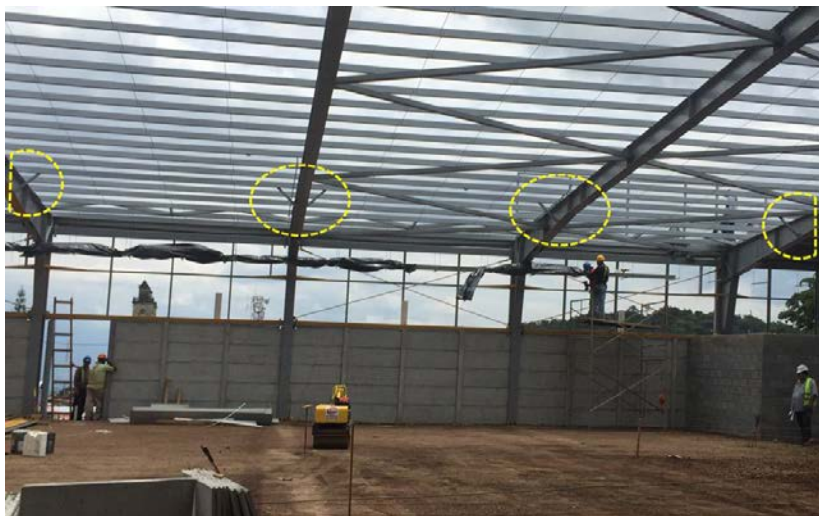
Figura 3.17. Instalación de bracones de techo proyecto en Puriscal, San José
