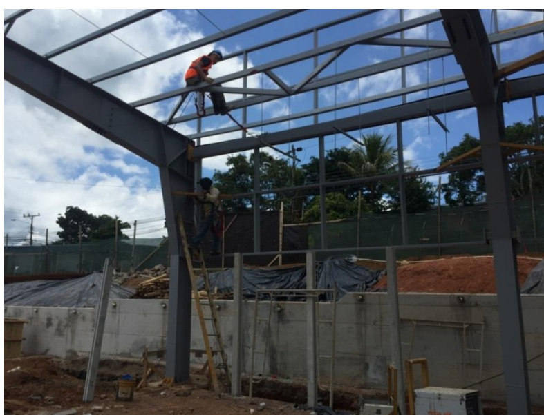
Figura 5.7 Instalación de bracones de pared
