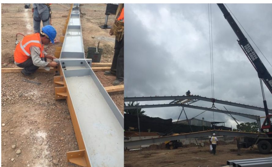
Figura 5.3 Instalación de vigas principales
