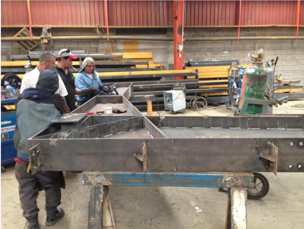
Figura 3.2. Proceso de soldado de columna en etapa de taller estructura con conexiones pernadas.
