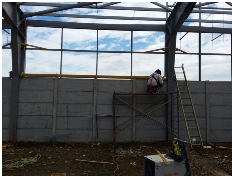
Figura 3.11. Instalación de vigas de amarre tipo soleras longitudinales proyecto en Puriscal, San José
