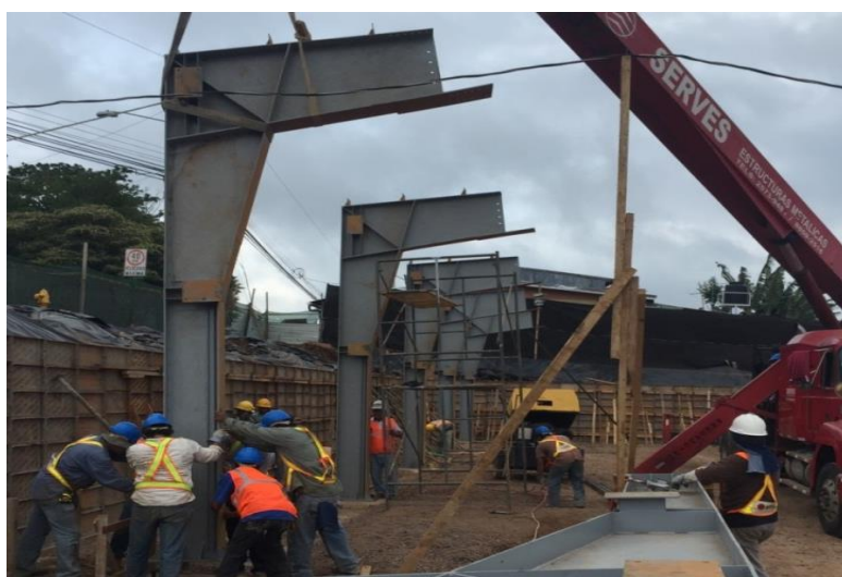
Figura 5.2 Instalación de columnas principales proyecto en Puriscal, San José
