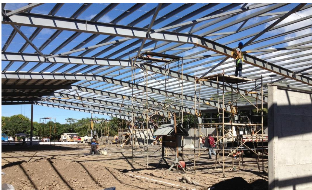
Figura 1.3. Estructura soldada construida en el año 2011 localizada en Orotina, Alajuela, Costa Rica.
