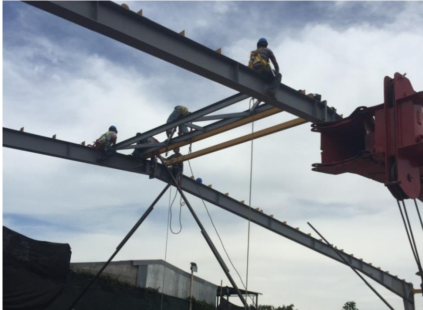
Figura 3.7. Colocación de vigas de amarre entre marcos proyecto en Puriscal, San José
