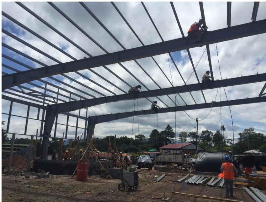
Figura 3.9. Instalación de clavadores de techo proyecto en Puriscal, San José
