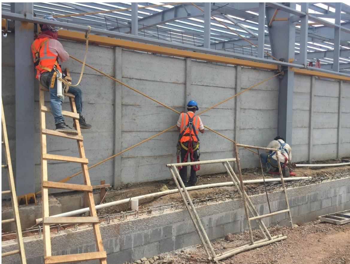
Figura 5.6 Instalación de tensores de pared en marcos longitudinales
