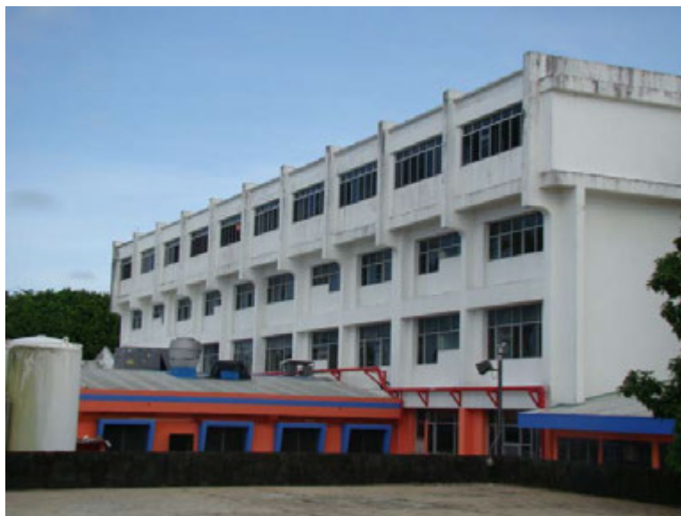
Fotografía 5.1. Vista del edificio de Encamados del H. Tony Facio.
