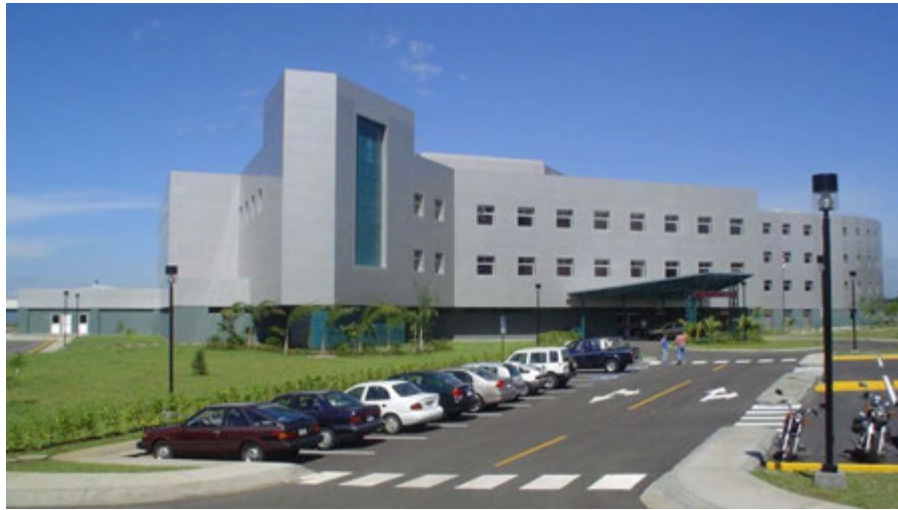
Fotografía 7.1. Fachada principal edificio de hospitalización, Hospital San Rafael.
