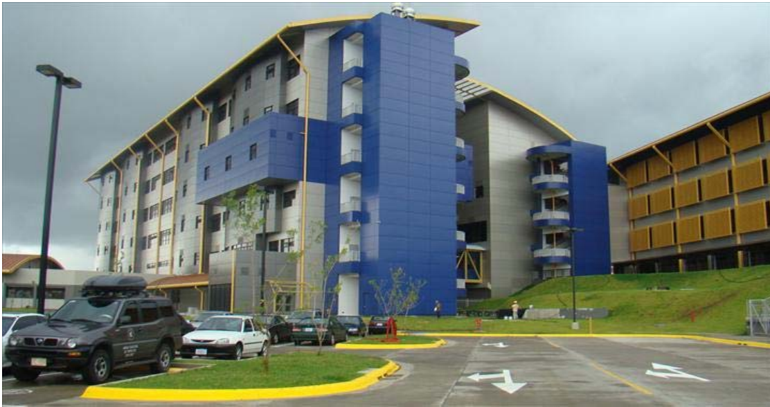
Fotografía 8.2. Vista del edificio de hospitalización, H. S. Vicente de Paul.
