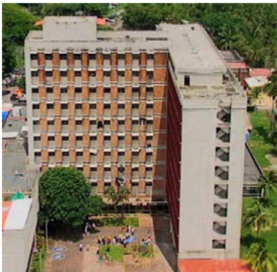
Fotografía 4.1. Vista lateral del edificio de hospitalización del H. Monseñor Sanabria.
