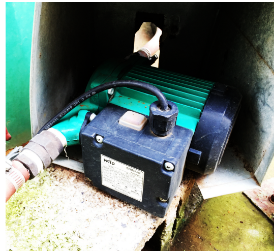
Figura 6. Bomba de recirculación, modelo PB-135JA de Wilo.
