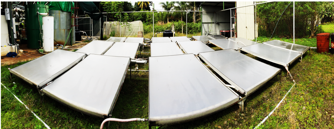
Figura 3. Unidad de colectores solares de placa plana que componen el sistema de aprovechamiento de energía solar en el SITRH en la EEAFBM.
