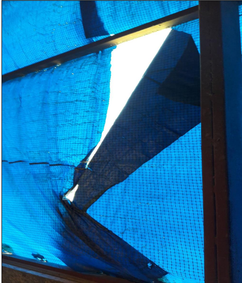
Figura 18. Fugas de aire en la instalación
