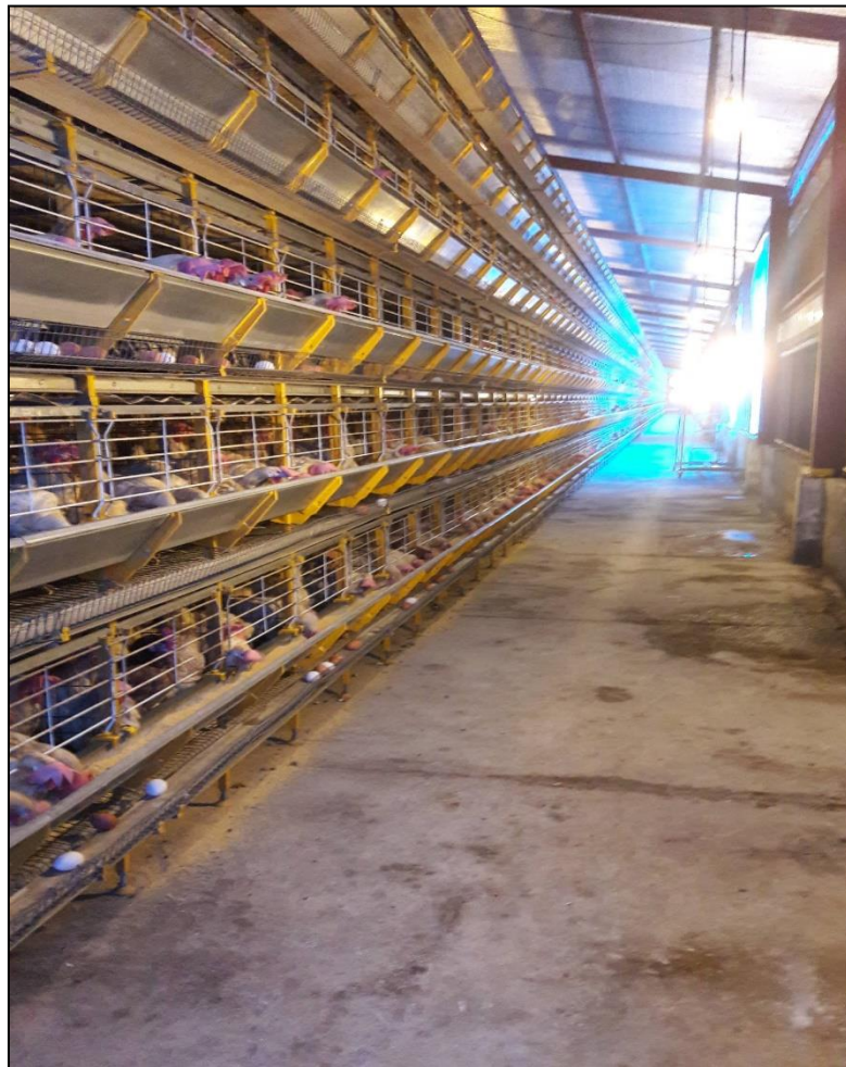
Figura 5. Vista interna de la instalación
